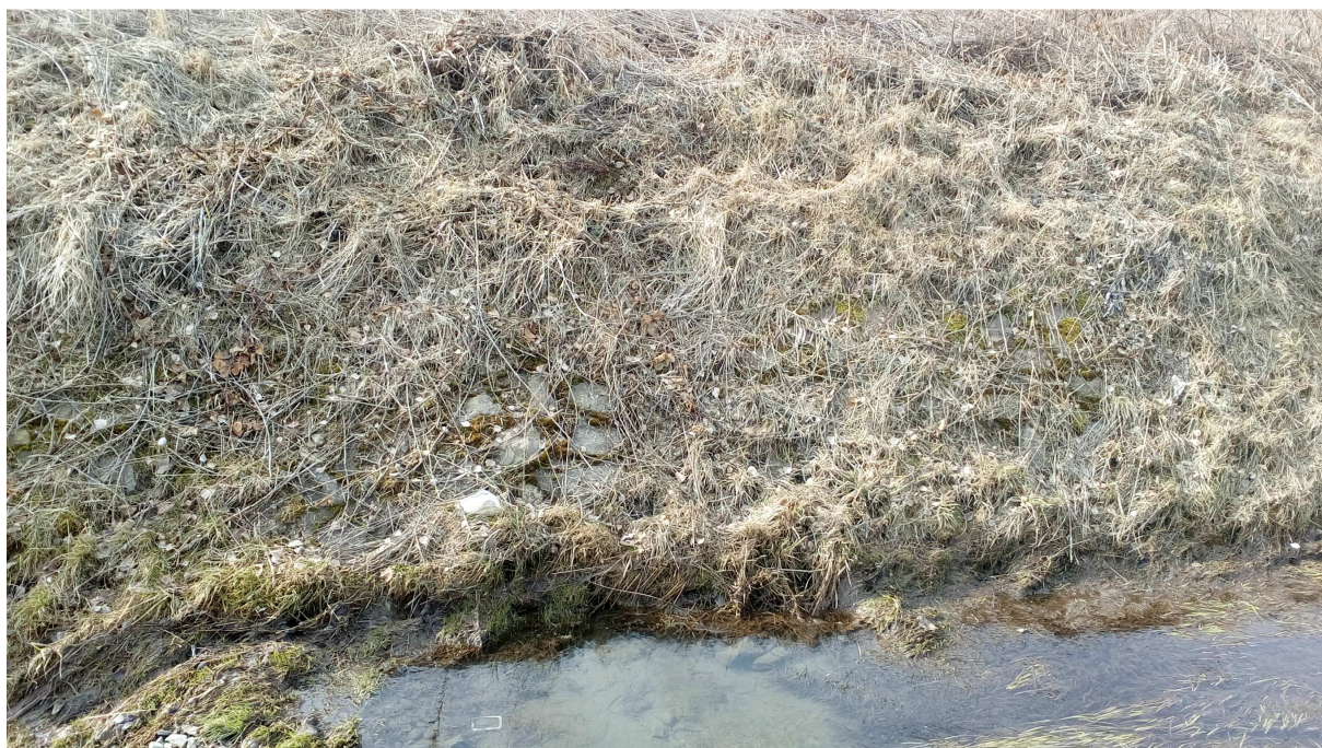
km 0,980, pohled na původní opevnění koryta toku kamenným záhozem
