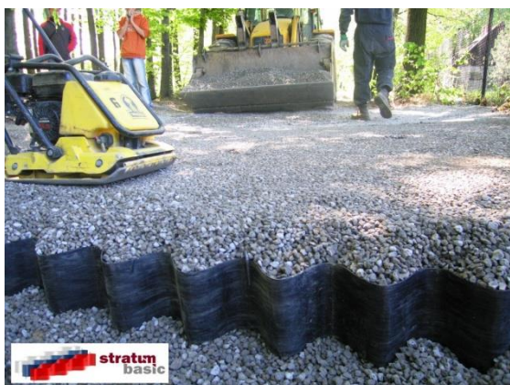
5. krok - úprava povrchu ( hutnění )
