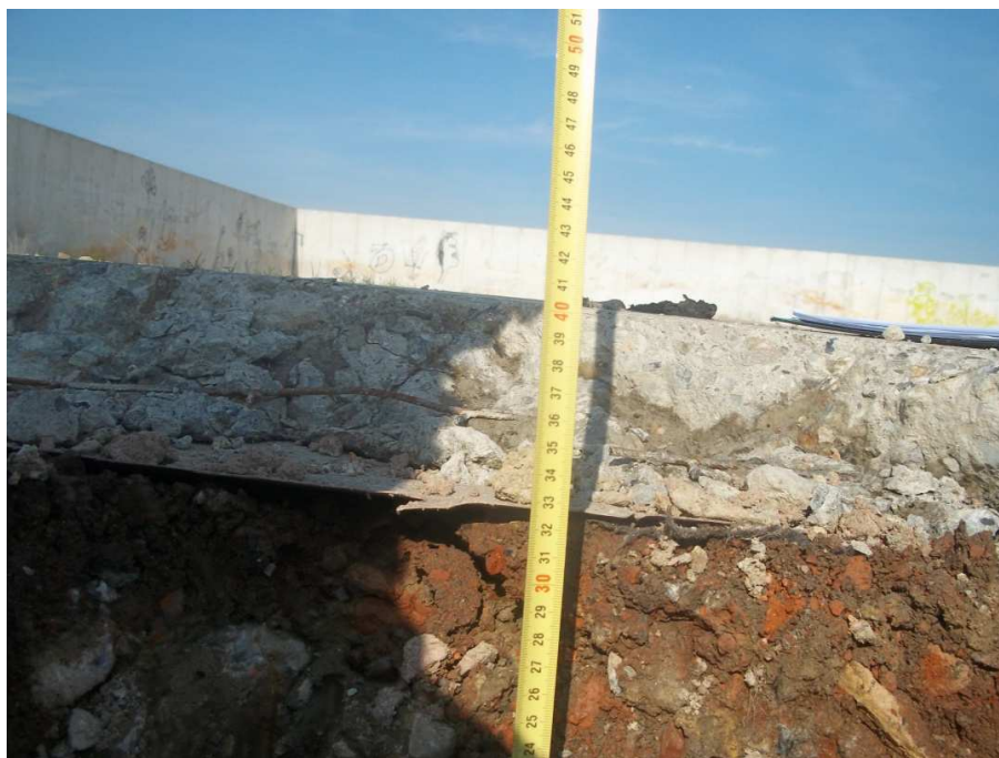
obr.č. 1 Pohled na sondu v podlaze
