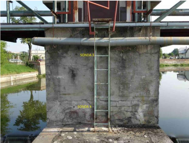
Foto 12. Umístění odvrtů 3 a 4.
