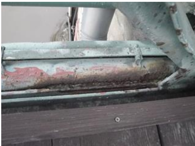
Foto 3. Pohled na potrubí nevhodně umístěné ke konstrukci lávky.
