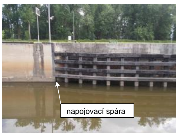
Pohled na sanovanou - opravovanou zeď
