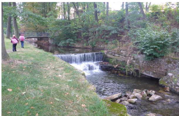
Obr. 20 SO 05 – Jez navržený k rekonstrukci (zásadní snížení a související úpravy nivelety), lávka nad jezem a křížení toku s infrastrukturou poblíž lávky.
