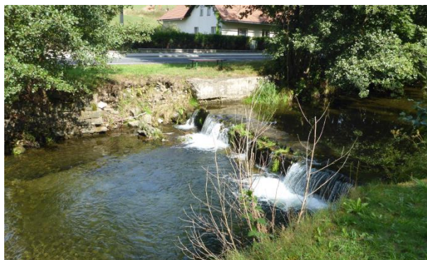
Obr. 13 SO 02 – Jez navržení k odstranění, rozšíření pravého břehu, úprava opevnění a nivelety dna
