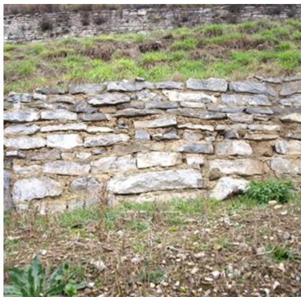
Obr. 4.2 - Vysprávka cementovou maltou
