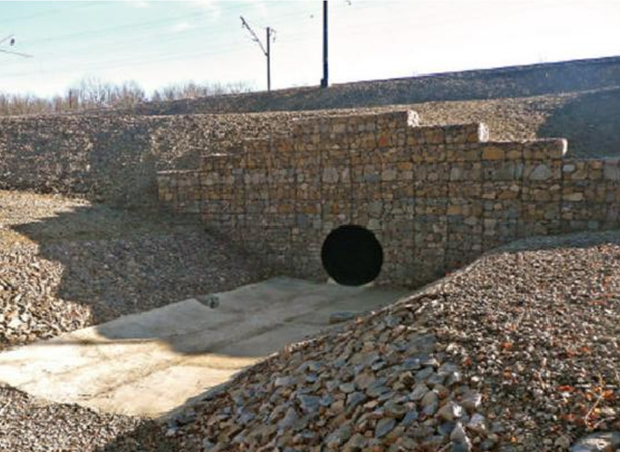
VIZUALIZACE NÁTOKOVÉHO A VÝTOKOVÉHO ČELA - GABIONOVÁ KONSTRUKCE
