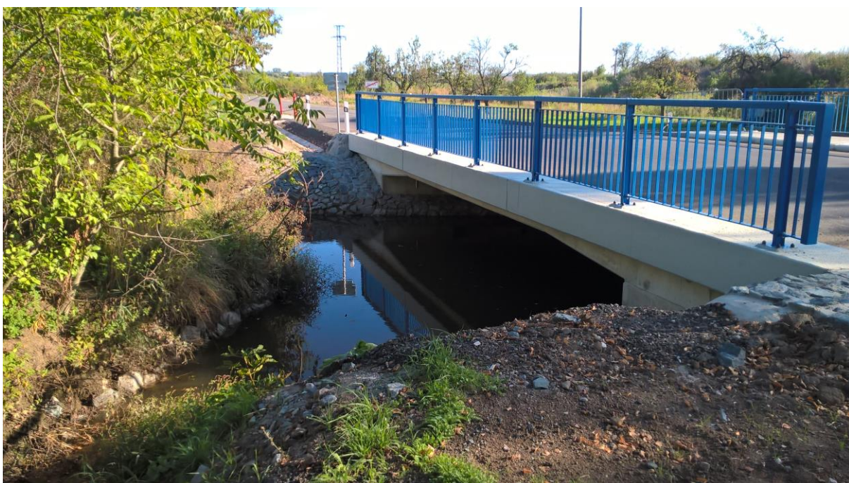
Mlýnský náhon nad silničním mostem Zbýšov, pohled od PB přítoku
