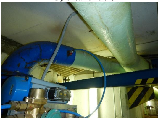
odbočení na MVE 2 – přímo pokračuje potrubí MZP
