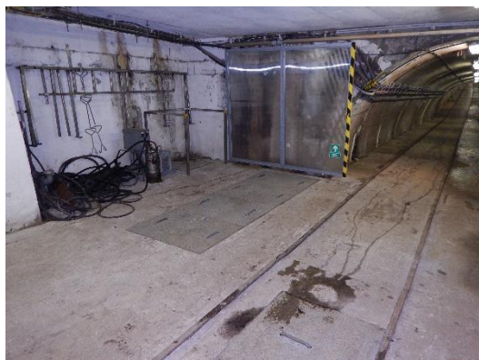
protiprůvanová zábrana na začátku strojovny – posuvná vrata
