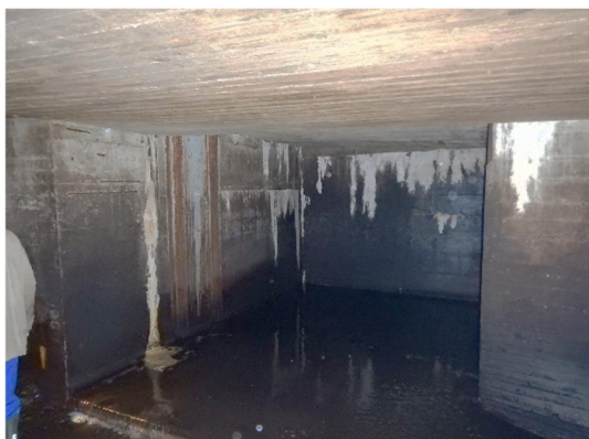
výstupní šachta a napojení na odpadní chodbu – na obr. zaplavená vodou
