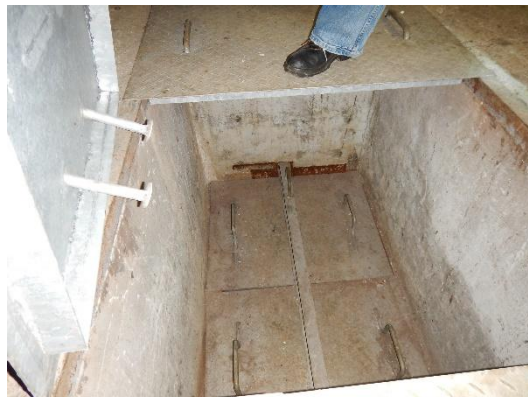
masivní ocelové poklopy pro uzavření šachty pro spuštění hrazení
