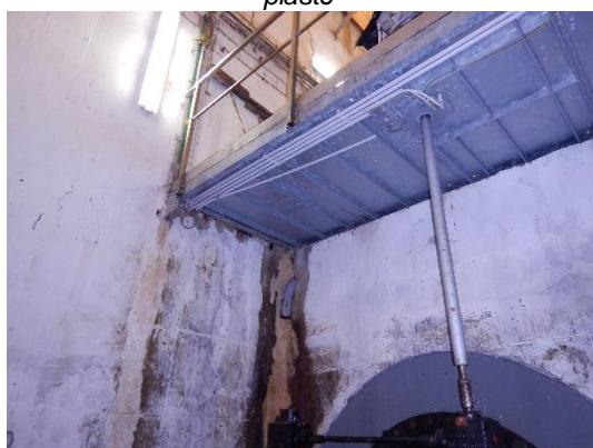
ovládací hřídel uzávěru
