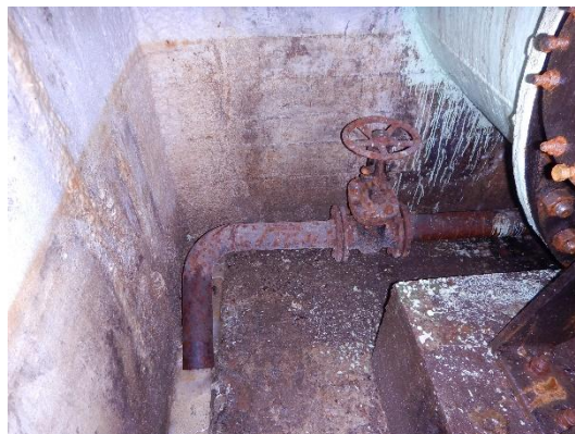
odvodnění DN 100 – pravá SV
