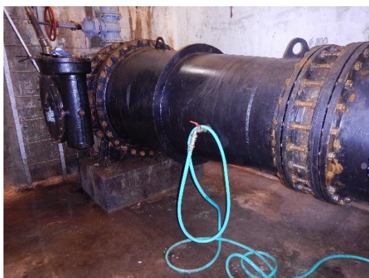
Přechodový kus levá SV s namontovanou montážní vložkou (na obr. vpravo)
