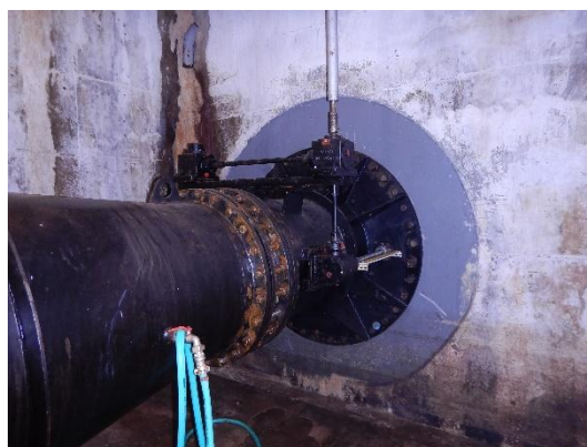
čelo tlumicí komory (šedé) s uchyceným kotevním kusem uzávěru a pohonem
