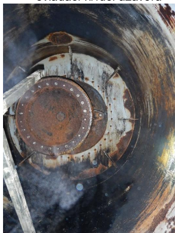
rozstřikovací uzávěr – část v tlumicí komoře
