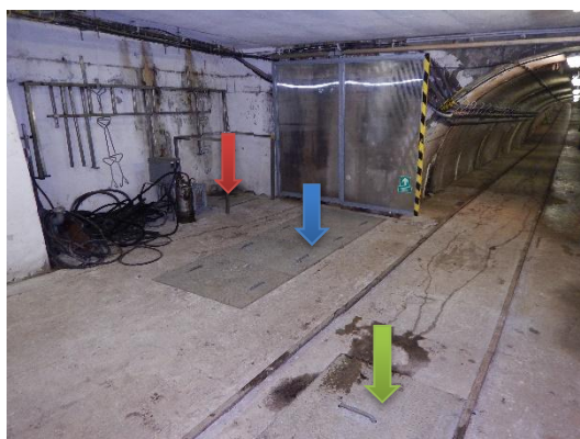
vstupní otvory do prostoru odpadní chodby a vzestupných šachet tlumicí komory ze strojovny SV
