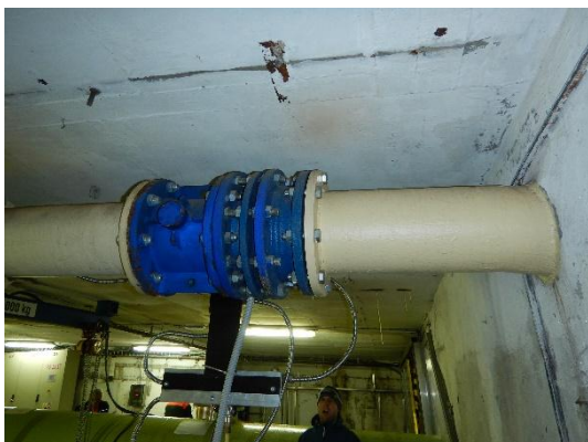
sestava armatur potrubí MZP a vstup do stěny strojovny
