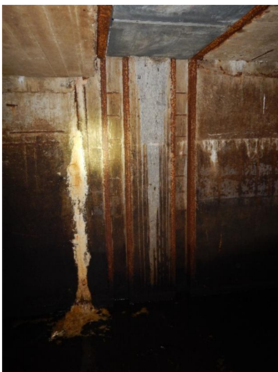
drážky pro zahrazení výstupních šachet, šachty pro hrazení jsou kryté masivními ocelovými poklopy
