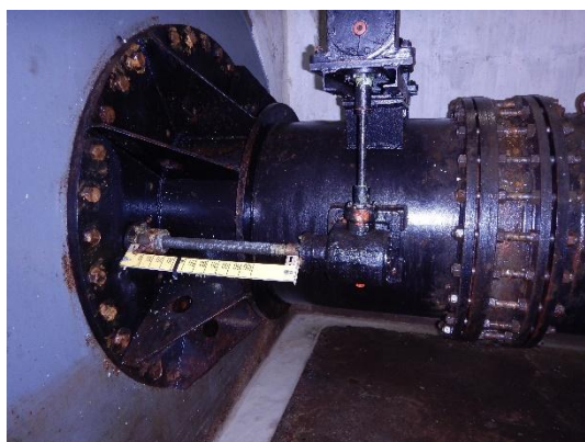
kotevní kus uzávěru s ovládáním přesuvného pláště
