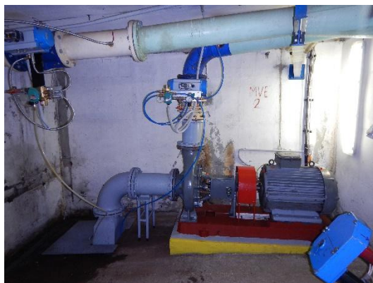
potrubí MZP podvěšené pod stropem s uzavírací armaturou
