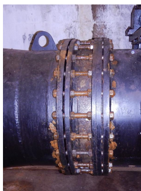
montážní vložka DN 800 PN 6
