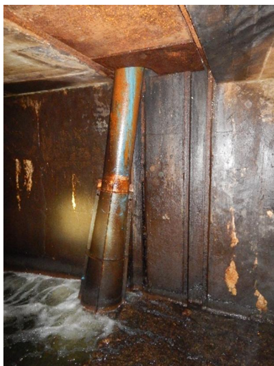
savka MVE1 kotvená k drážce prov. hrazení
