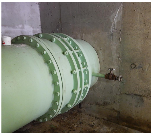
odbočení z vodárenského potrubí s koncovkou pro nasazení požární hadice
