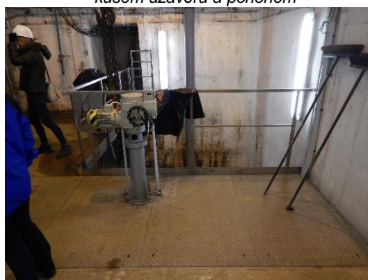
servomotor umístěný na stojanu na podestě
