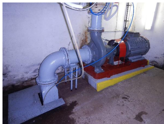
MVE 2 – odstředivé čerpadlo
