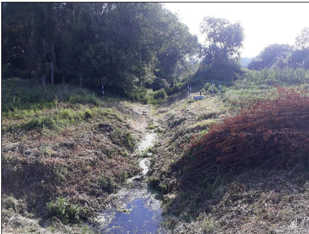
6. Odtokové koryto pod spodní výpustí
