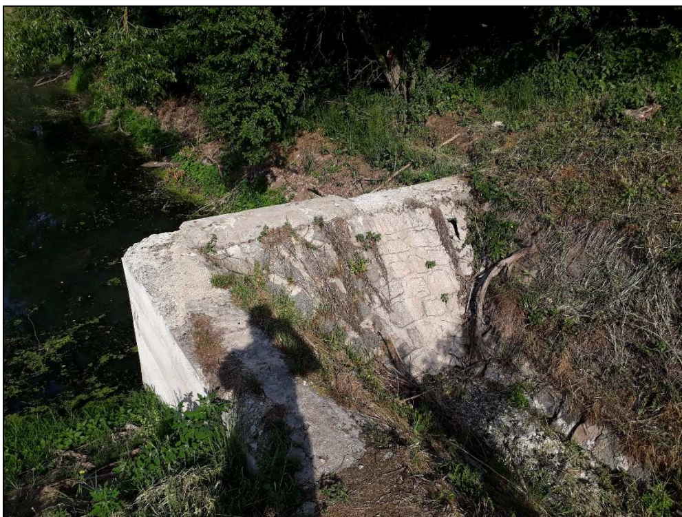
8. Přelivná hrana bezpečnostního přelivu
