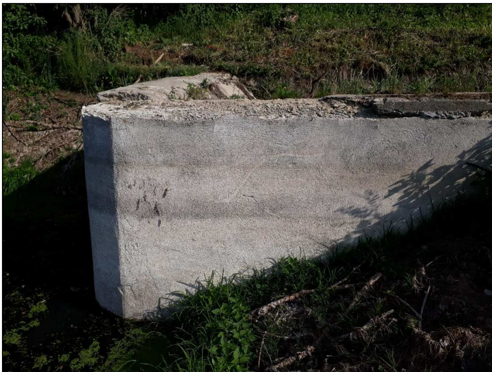
9. Přelivná hrana bezpečnostního přelivu
