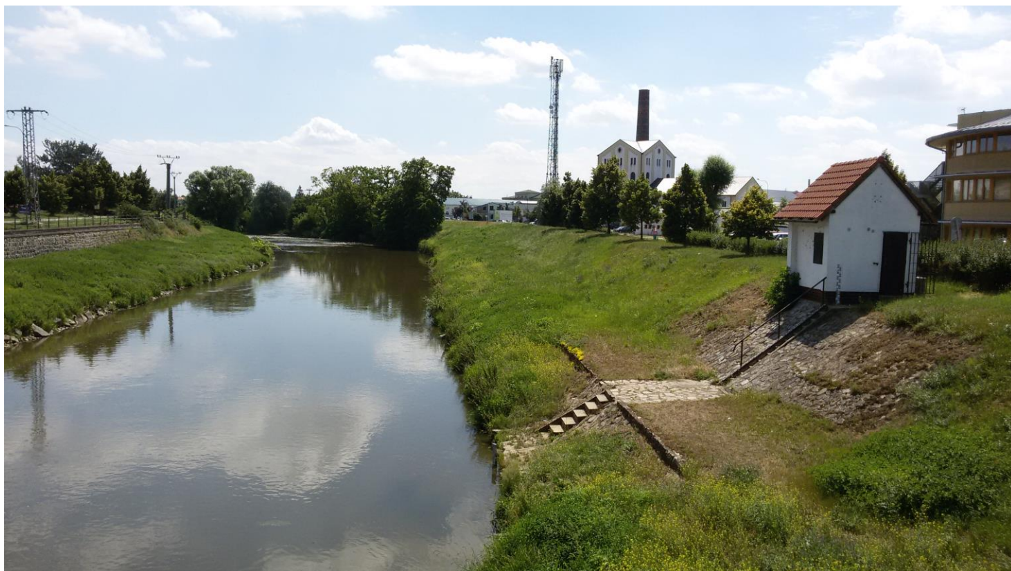
Obr.1 – Objekt měřicí stanice
