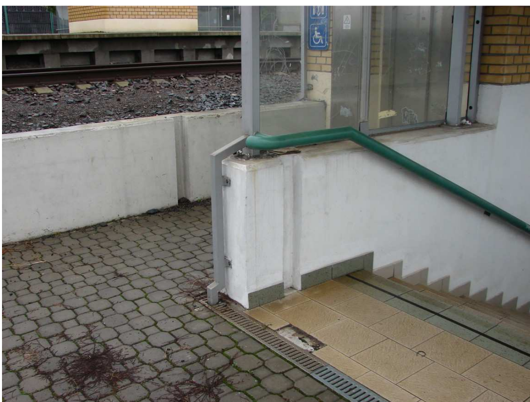
47. GRYGOV, drážky pro mobilní hrazení u železničního podchodu
