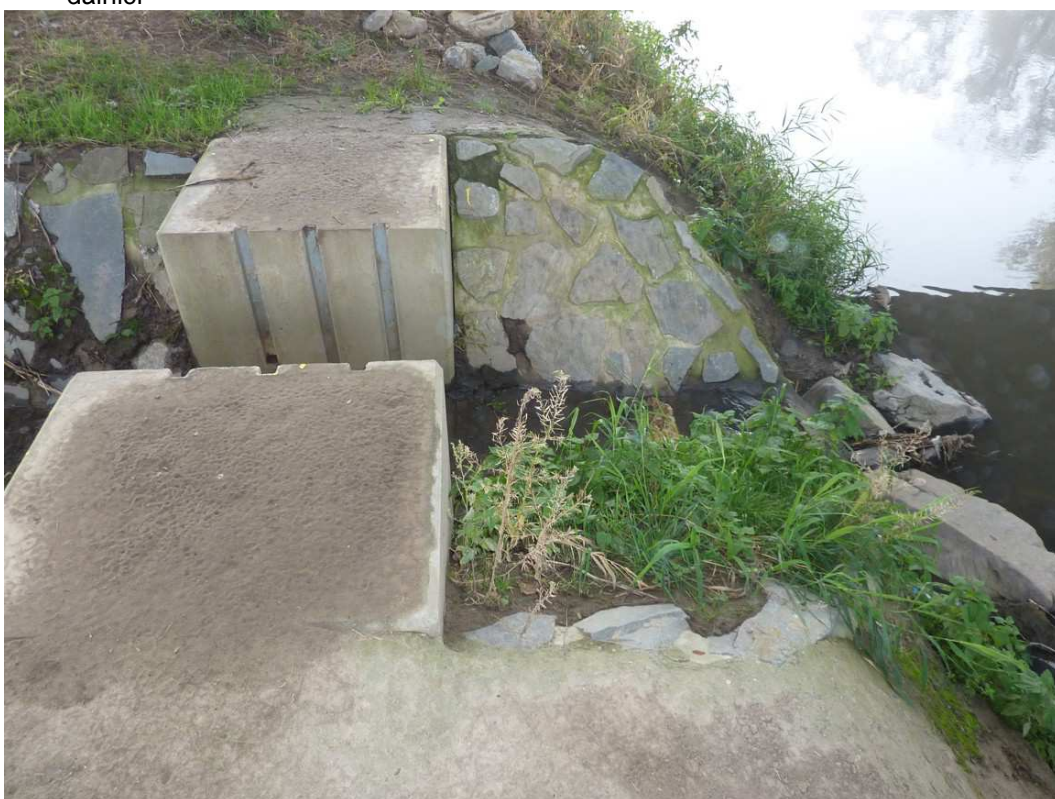
22. km 229,30 detailní pohled na vyústění od odvodnění dálnice v témže místě (>>>>)
