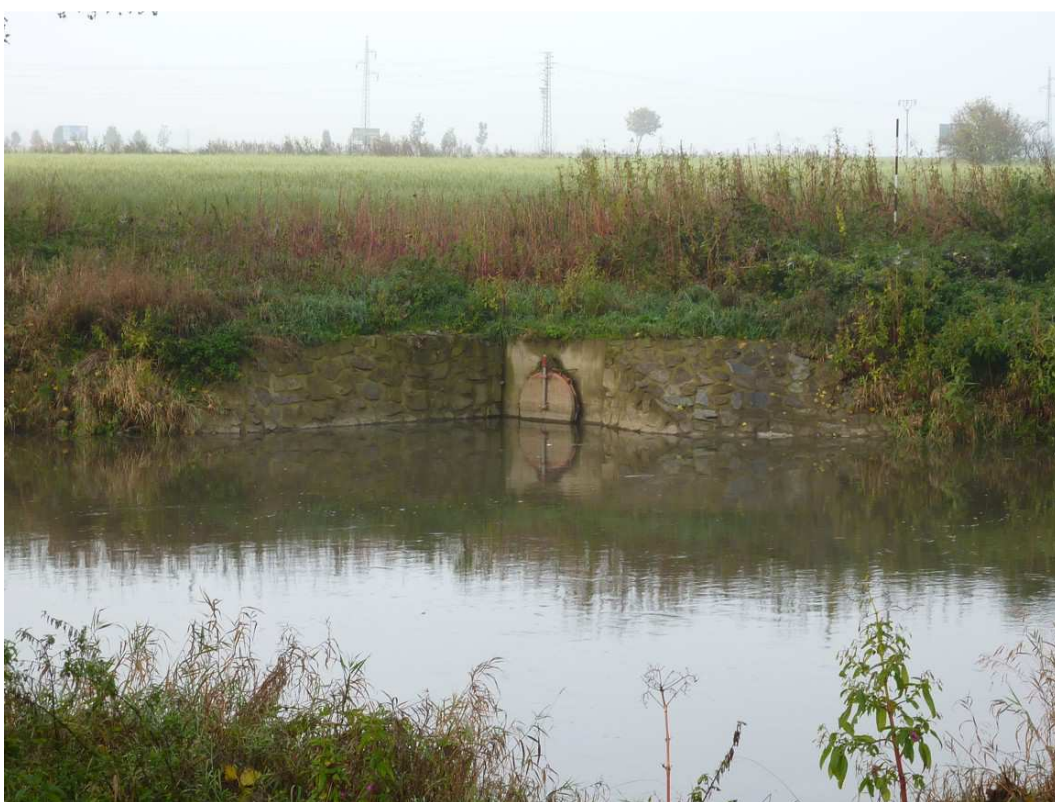
26. km 229,80 vyústění na pravém břehu opatřené zpětnou klapkou
