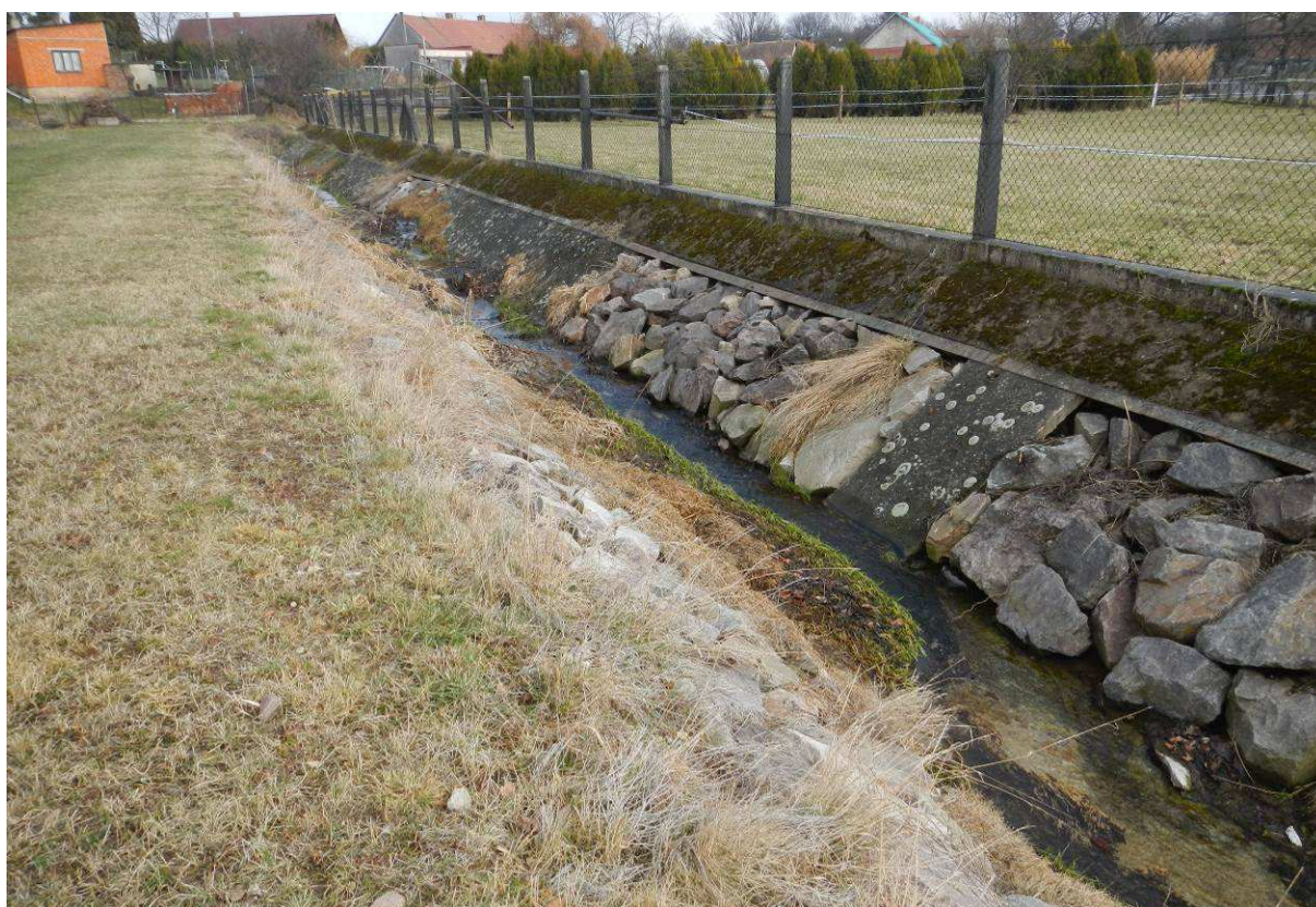
obr. 4 – Opevnění betonovými panely a záhozem nad mostem, na PB stavenišťě
