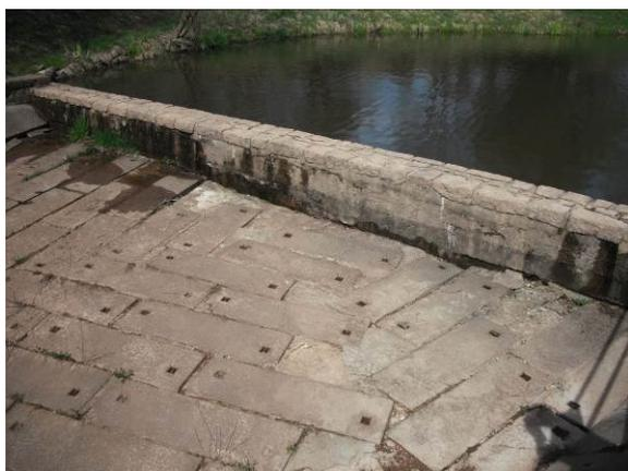
Obrázek 3. Průsak pod korunou čelního bezpečnostního přelivu
