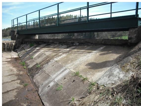
Obrázek 4. Odtržená koruna bočního bezpečnostního přelivu od spodní konstrukce
