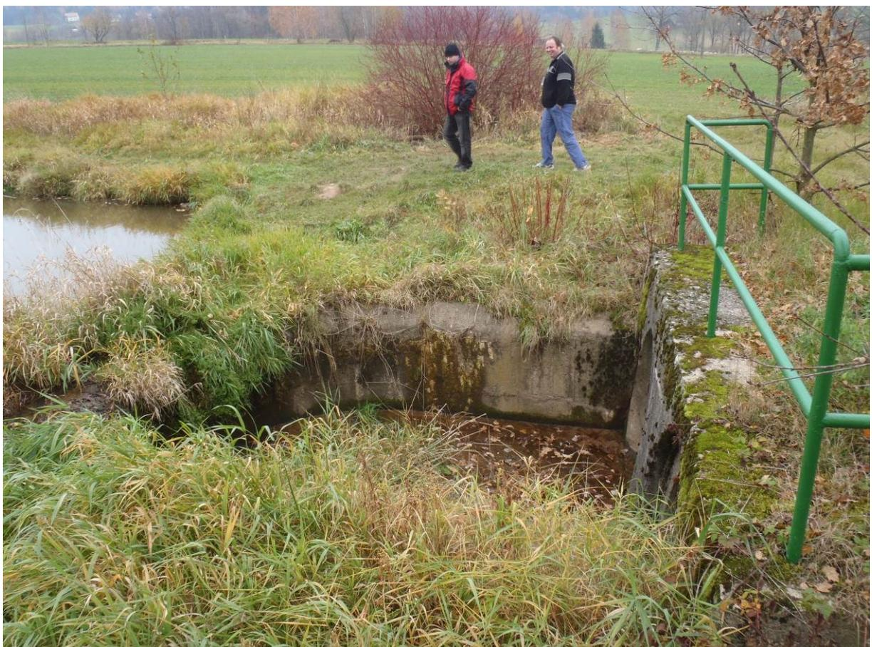
Obrázek 3. Průsak hrázi podél objektu bezpečnostního přelivu
