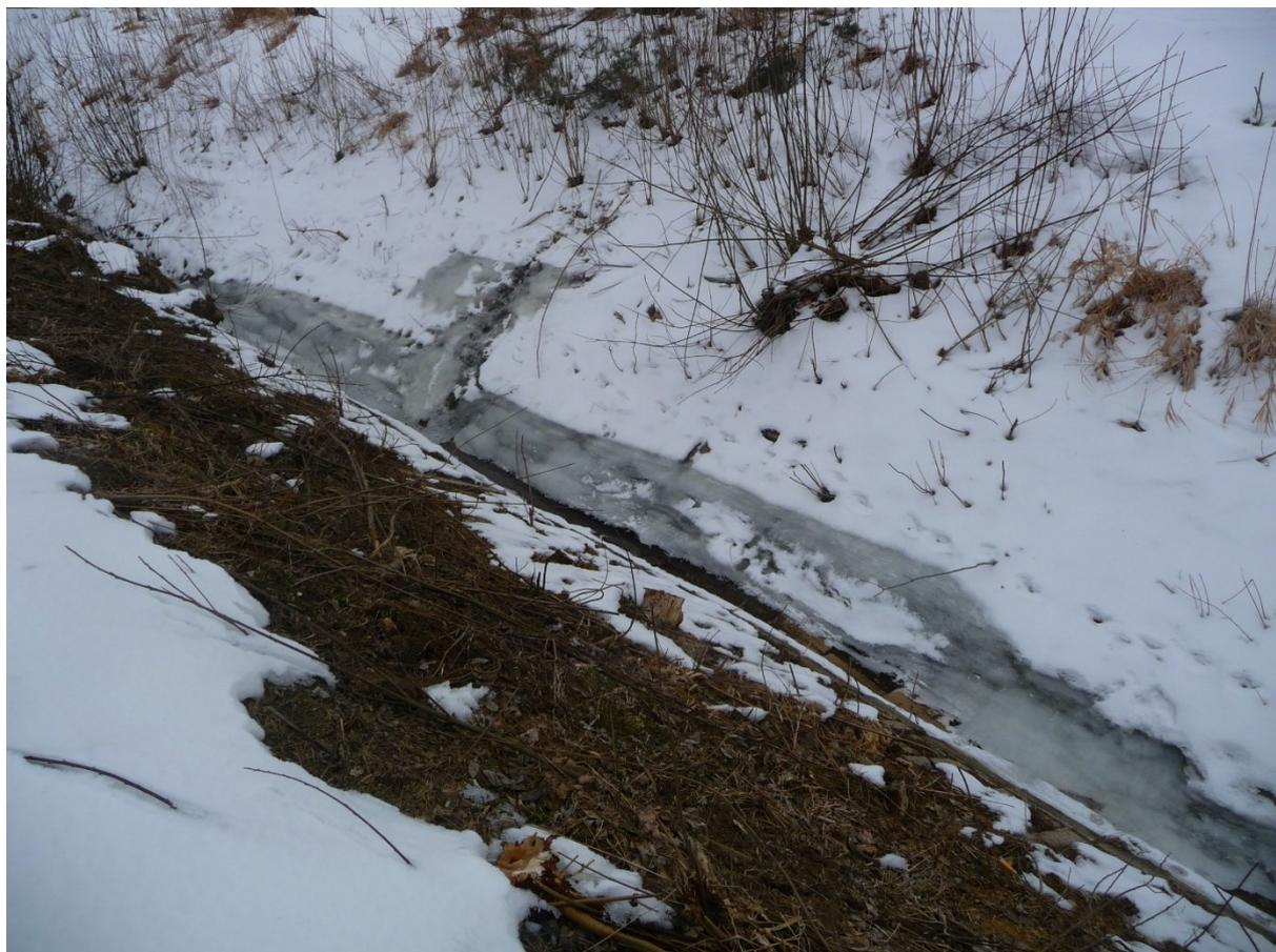
Obrázek 3. Průsak vody na vzdušném líci boční hráze v km 0,240.
