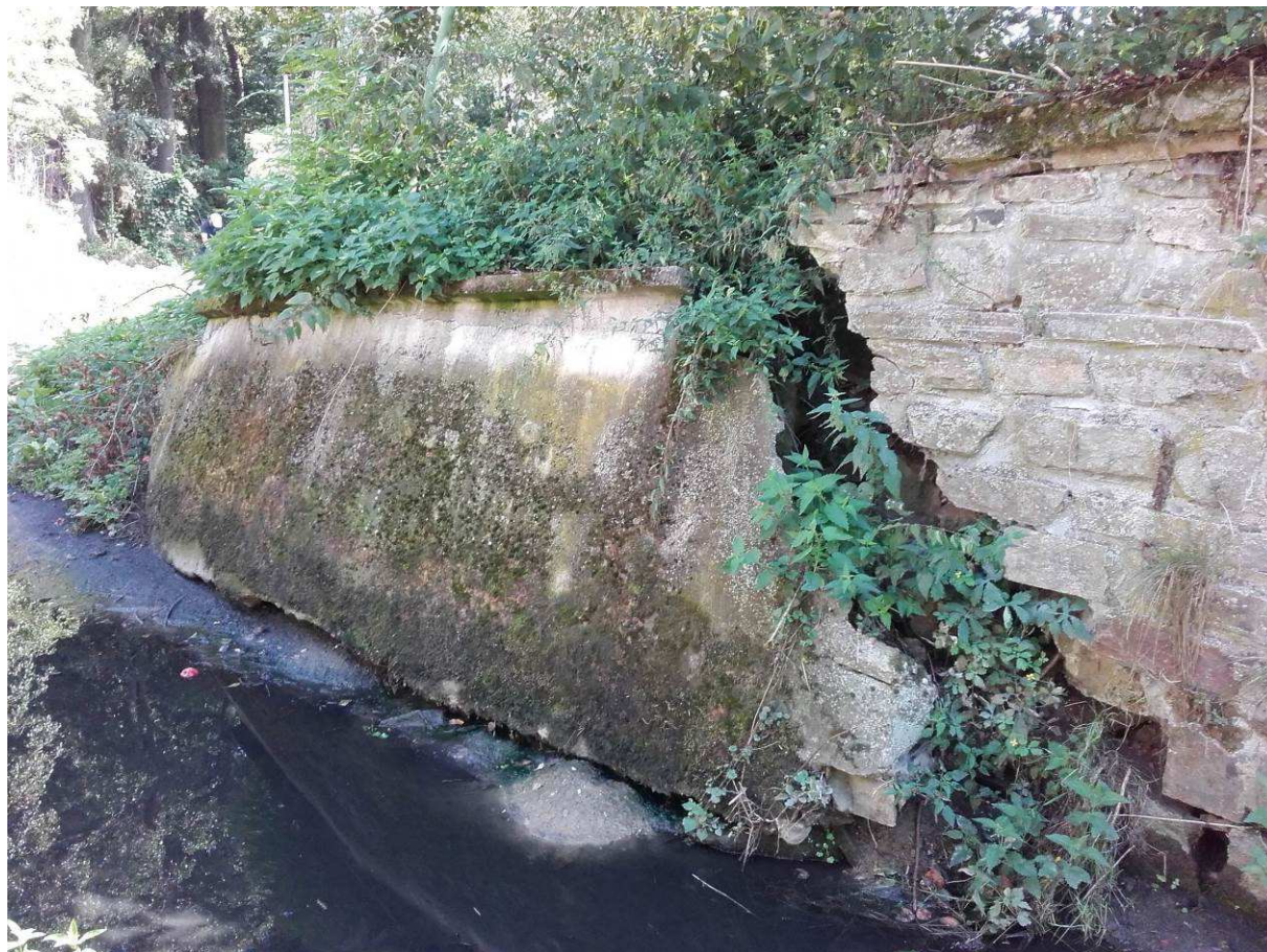
obr.1 Pohled na zborcenou část PB zdi
