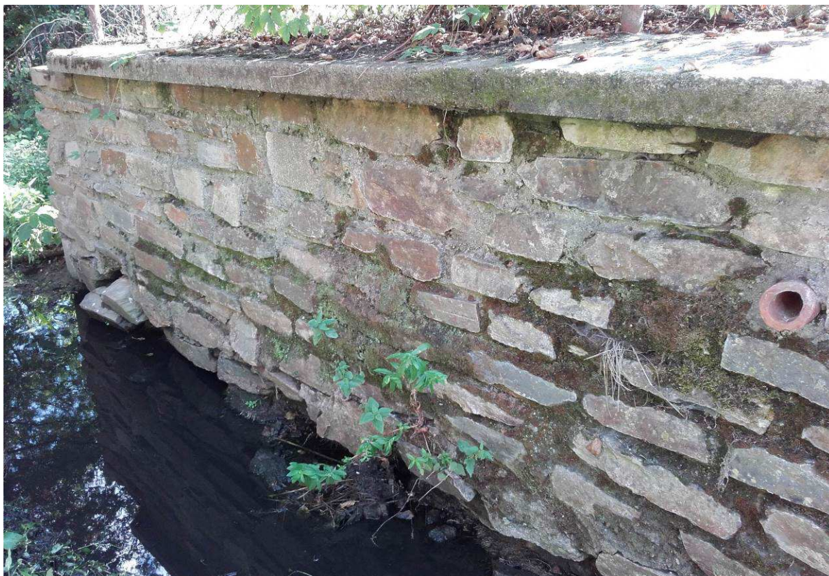
obr.2 Kaverna v patě pravobřežní zdi
