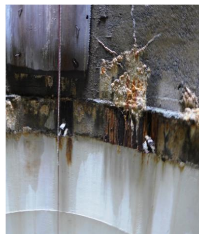
obr. 17 a 18 profil kolejnice zasahující do vnitřního prostoru, původní montážní otvor průsaky v okolí přechodové spáry a montážního otvoru
