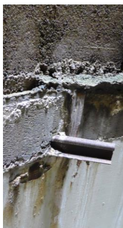
obr. 17 a 18 profil kolejnice zasahující do vnitřního prostoru, původní montážní otvor průsaky v okolí přechodové spáry a montážního otvoru
