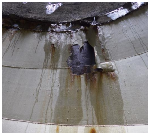
obr. 19 a 20 defekt nátěru přechodového kolene, viditelné projevy průsaků
