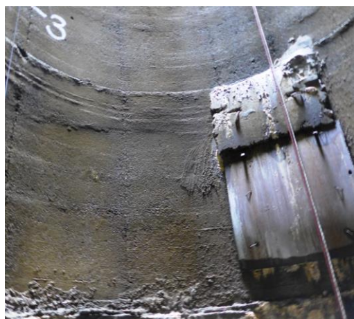
obr. 17 a 18 profil kolejnice zasahující do vnitřního prostoru, původní montážní otvor průsaky v okolí přechodové spáry a montážního otvoru
