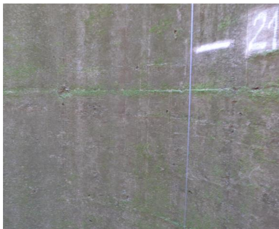
obr. 13 a 14 prokreslení spár průsaky, staničení + 20,5 m a + 18 m
