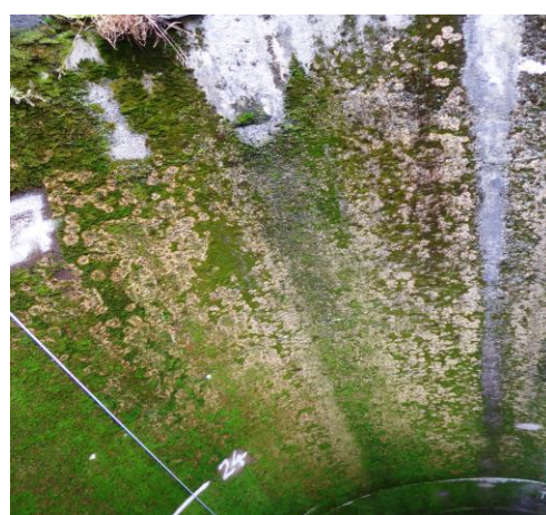
obr. 7 a 8 vizuální prohlídka, vegetace na povrchu stěn v horní části věže přelivu
