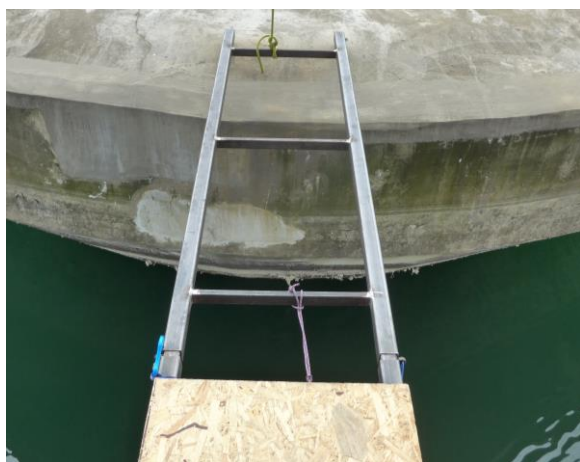
obr. 2 a 3 instalace a kotvení přístupové lávky pro provedení průzkumných prací
