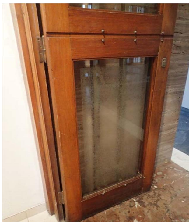
Dveře na levé straně vestibulu – vstup do vedlejších prostor Pohled z rubové strany – chybějící madla a detail závěsu
