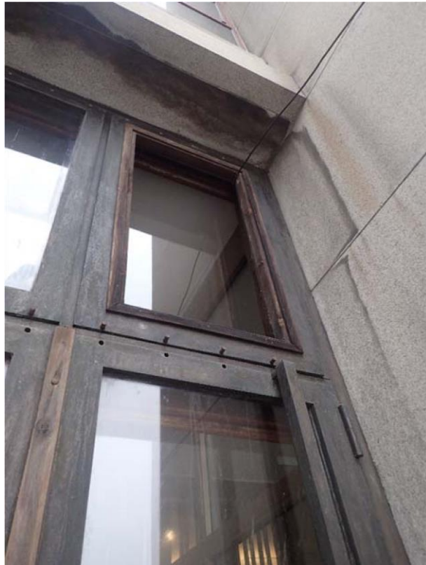
Krajní dveře z levé strany – detail chybějících madel a druhotného rámu zasklení
