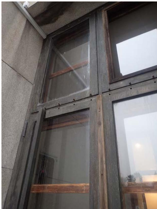
Krajní dveře z levé strany – detail chybějících madel a druhotného rámu zasklení
