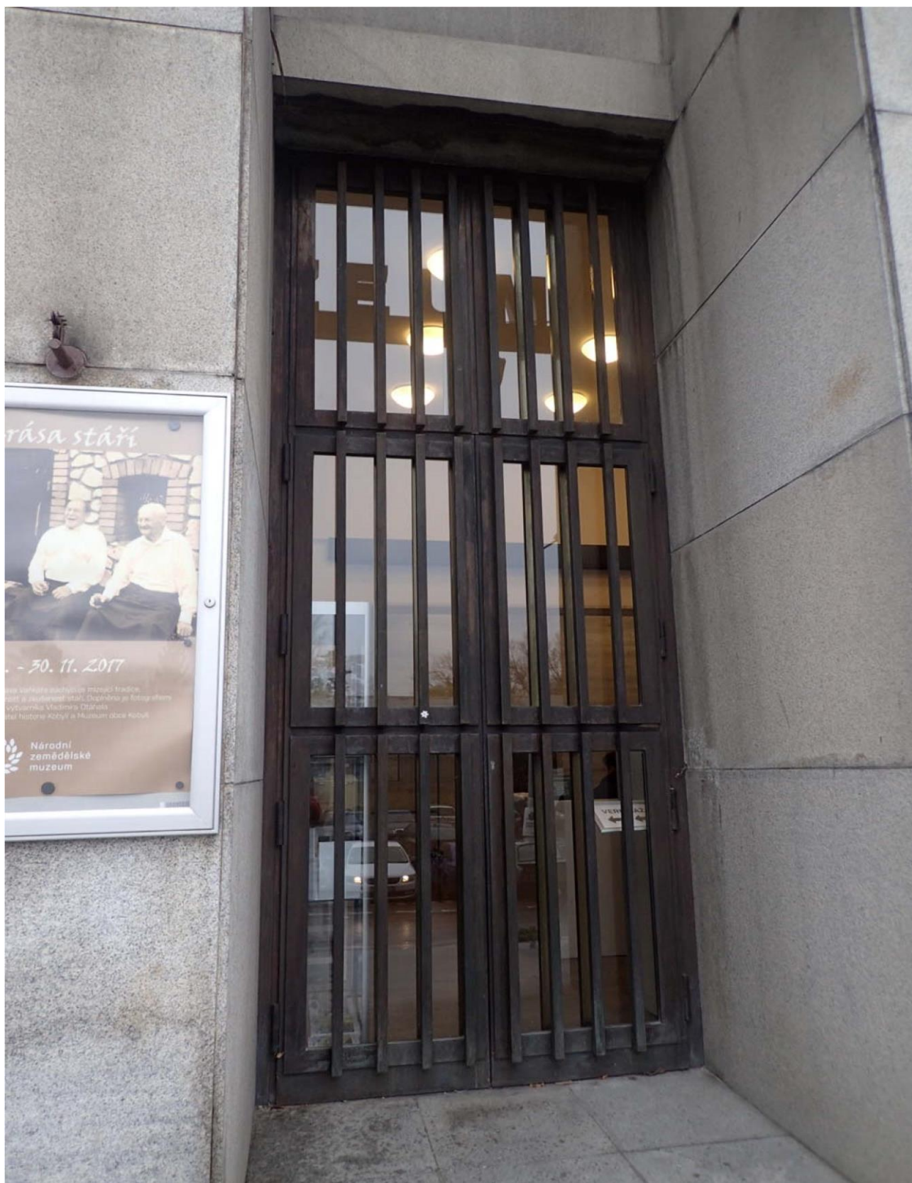
Krajní pravé dveře – pohled z exteriéru
