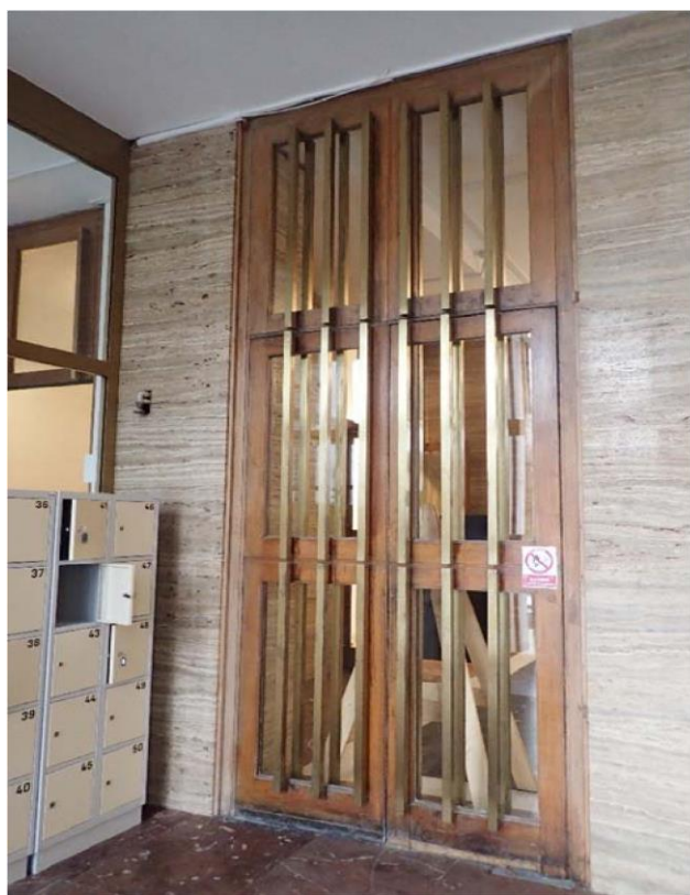
Levé dveře – pohled ze vstupu
