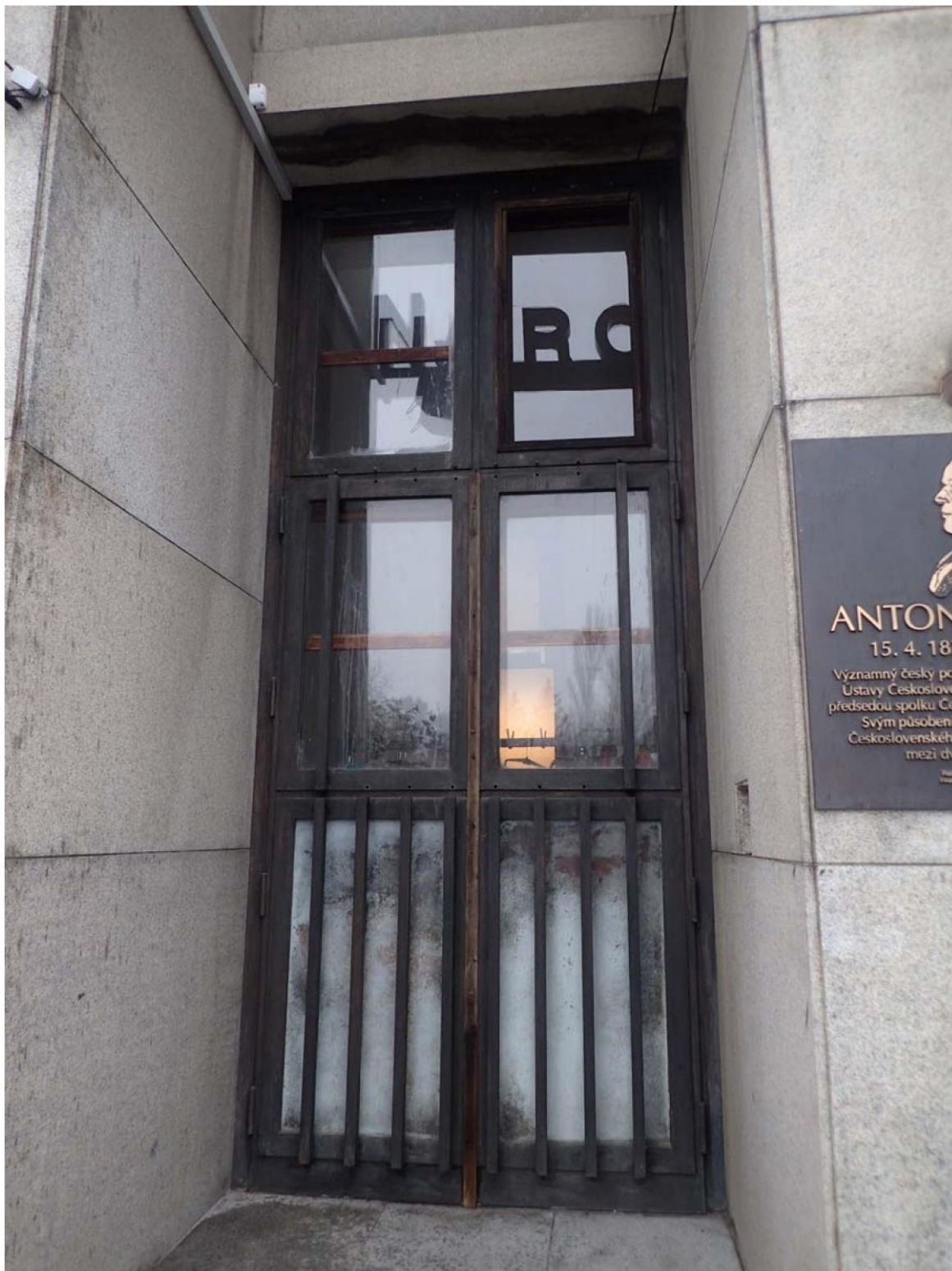
Krajní dveře z levé strany – pohled z exteriéru
