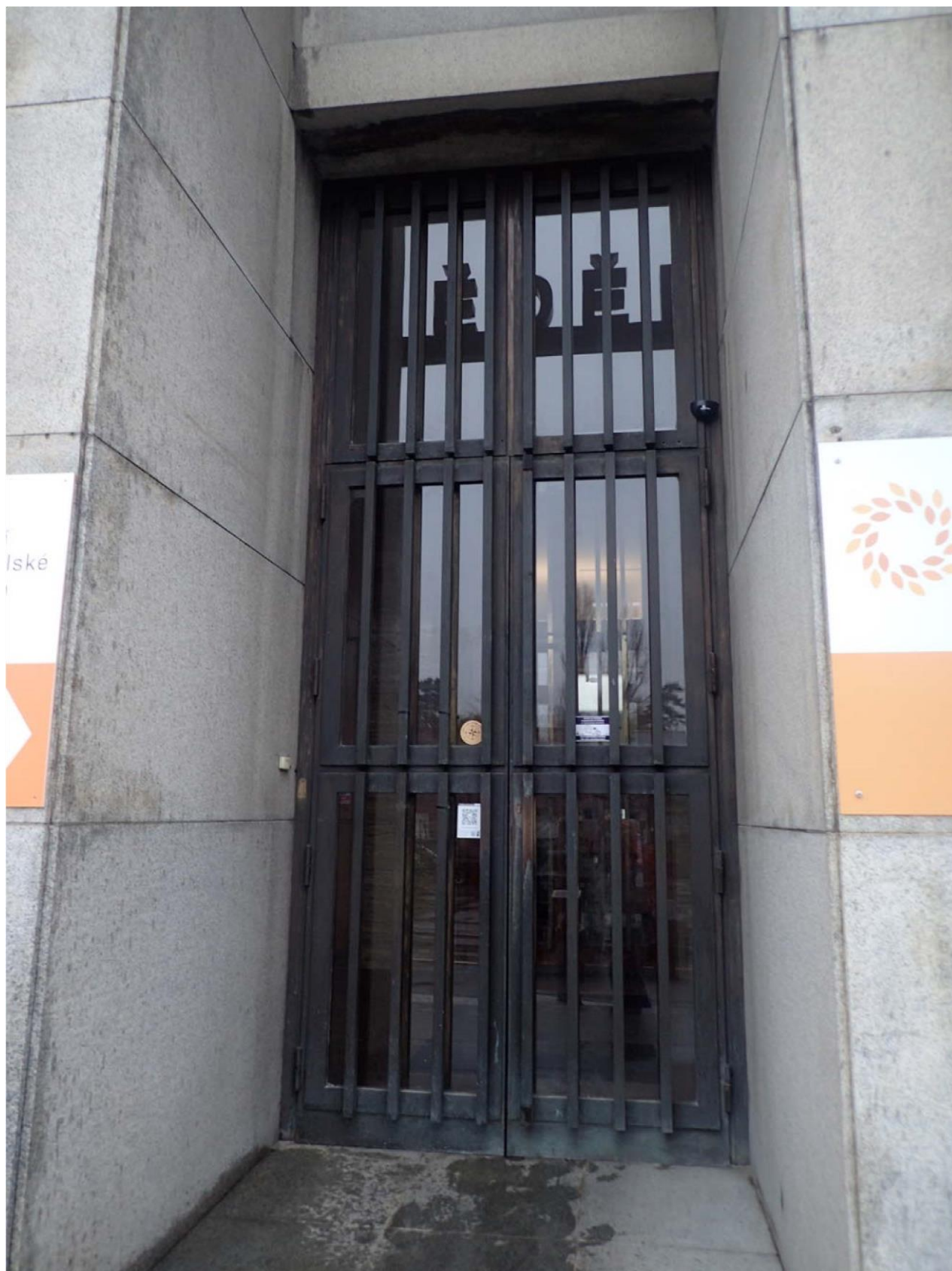
Prostřední dveře – pohled z exteriéru
