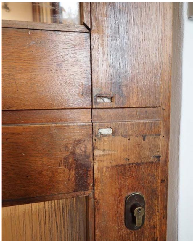
Dveře do šatny – poškození kolem zámků
