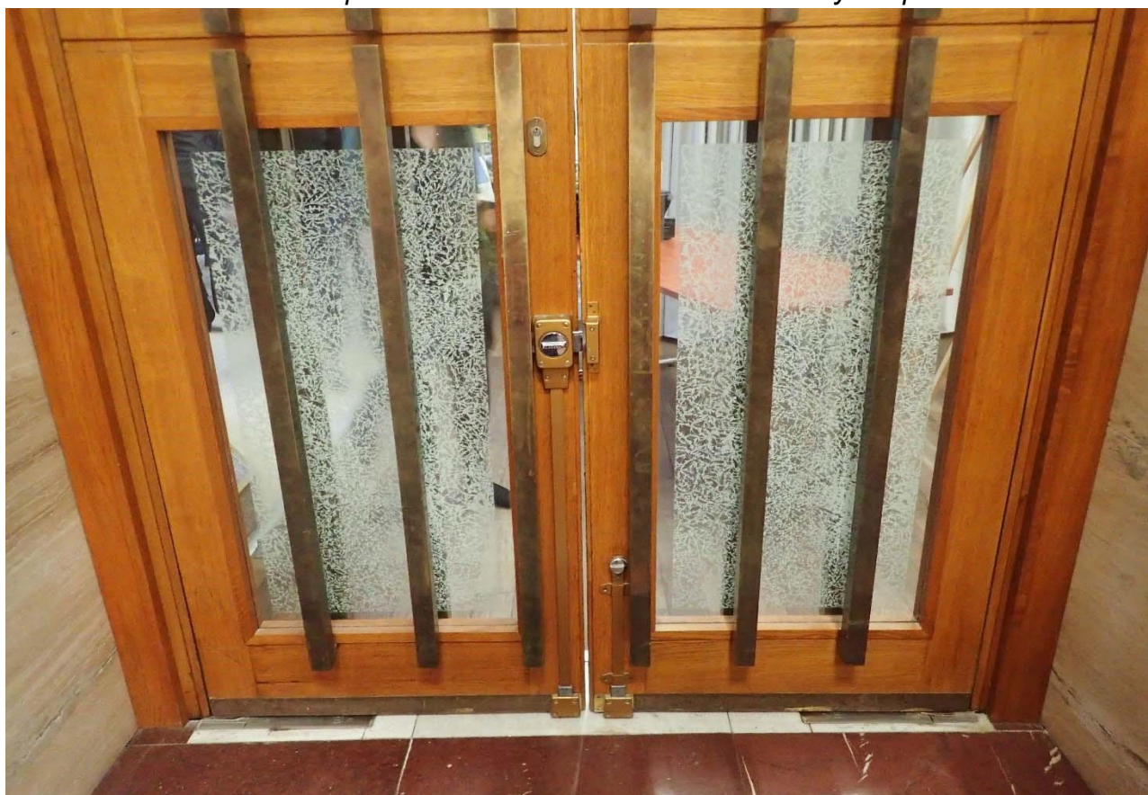
Dveře na pravé straně vestibulu – detail druhotných úprav
