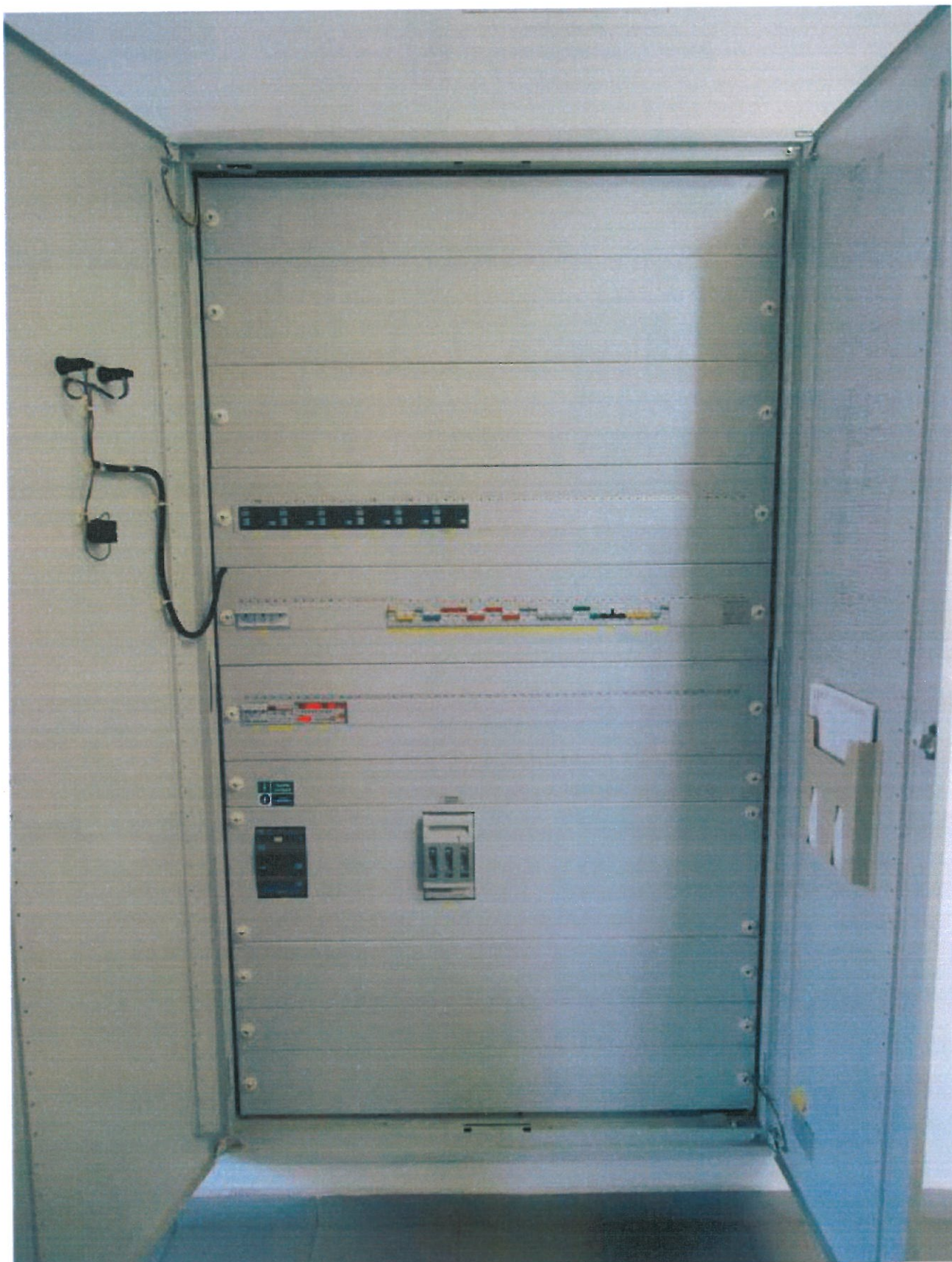
Hlavní rozvaděč v přízemí budovy zůstane stávající, ale upraví se jeho uspořádání a dostrojí se
