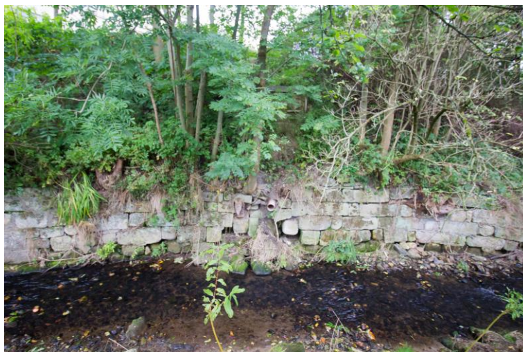
Foto č. 3: pohled na PB zeď v místě bývalého vyústění z náhonu, který nebude v rekonstruované zdi obnoven, zeď bude v optimální poloze vůči toku.
