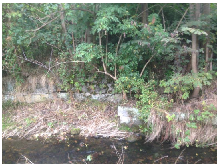
Foto č. 3: pohled na PB zeď v místě bývalého vyústění z náhonu, který nebude v rekonstruované zdi obnoven, zeď bude v optimální poloze vůči toku.
