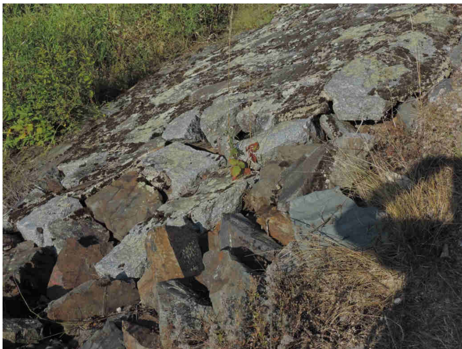
Dlažba s výplní spár cementovou maltou , stáří asi 70 – 80 let. Výplň spár začíná již být degradována a konstrukce prorůstá (zatím) bylinnou vegetací. Dochází k narušení vazby a po přivalových deštích k lokálnímu narušení konstrukce.....
