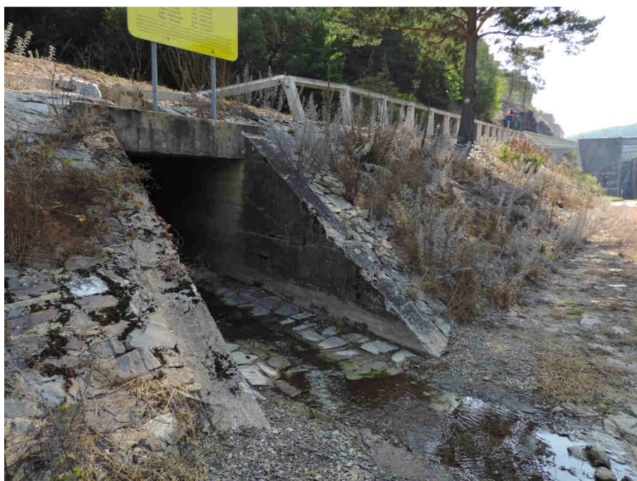
Dlažba s výplní spár cementovou maltou, stáří asi 70 – 80 let. Výplň spár začíná již být degradována a konstrukce prorůstá (zatím) bylinnou vegetací
