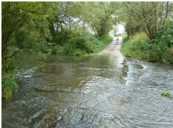
Obr. 6: Betonový brod v ř. km 31,714
