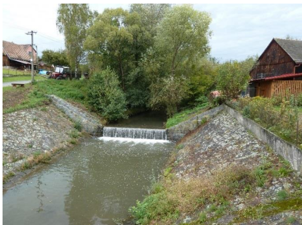
Obr. 21: Kamenný spádový stupeň v ř. km 33,506
