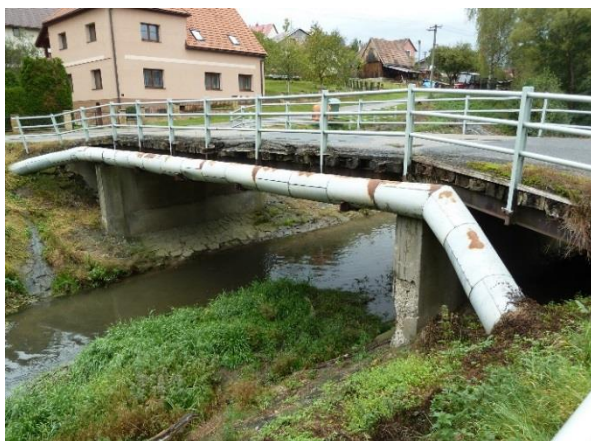
Obr. 19: Silniční most v ř. km 33,479 – nánosy ve dně pod mostem
