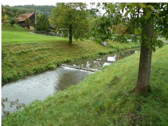
Obr. 17: Dřevěný stupeň v korytě pod lávkou pro pěší v ř. km 33,151
