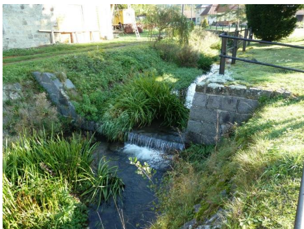
Obr. 38: Kamenný spádový stupeň
