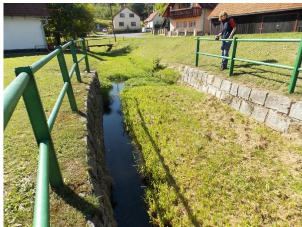
Obr. 48: Pohled na zanešené koryto, obdélníkový profil
