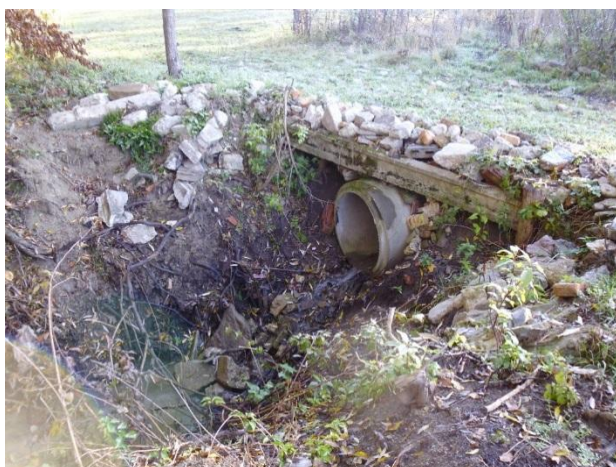
Obr. 19: Náhrada propustku brodem
