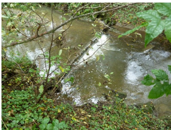
Obr. 57: Dřevěný stupeň v korytě Smolinky
