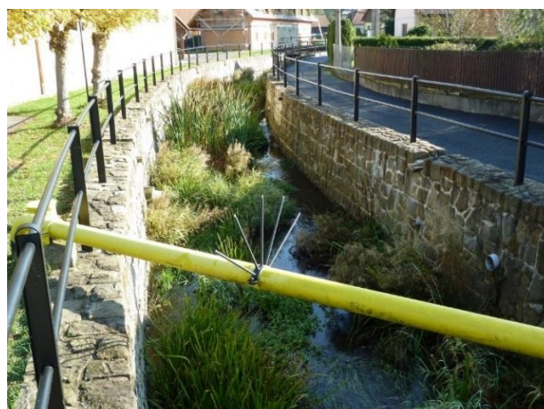
Obr. 37: Pohled na zanešené koryto, obdélníkový profil
