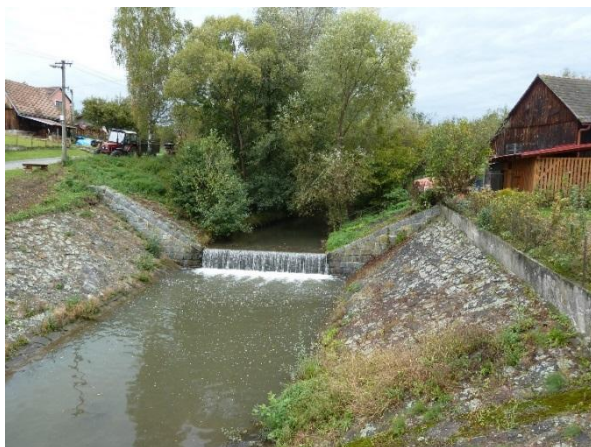
Obr. 77: Kamenný spádový stupeň v ř. km 33,506
