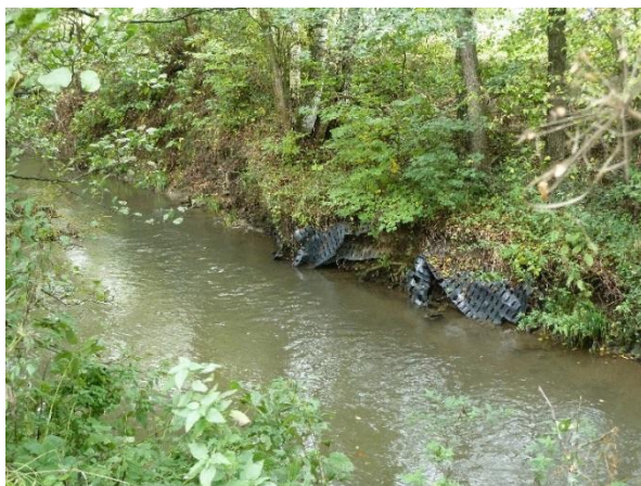
Obr. 79: Narušené gumové opevnění v patě levého břehu
