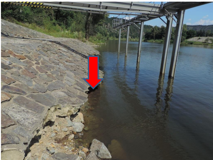
Dlažba na cementovou maltu. Podceněná hmotnost kamenů v záhozové patce měla při povodni za následek její odplavení a vytvoření výmolu pod konstrukcí, který byl bezprostřední příčinou poruchy.
