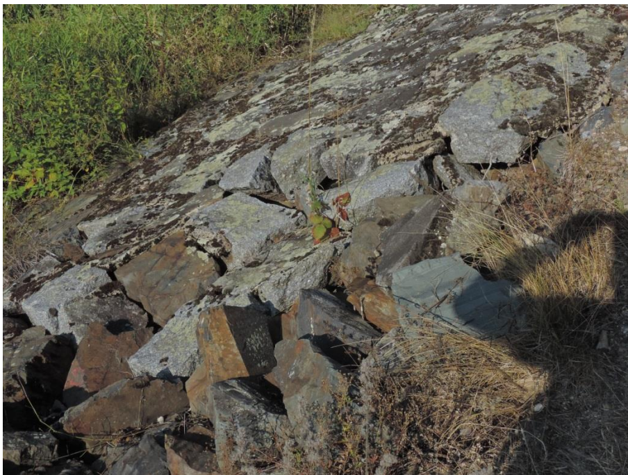
Dlažba s výplní spár cementovou maltou , stáří asi 70 – 80 let. Výplň spár začíná již být degradována a konstrukce prorůstá (zatím) bylinnou vegetací. Dochází k narušení vazby a po přivalových deštích k lokálnímu narušení konstrukce. To však není chyba v provedení konstrukce
