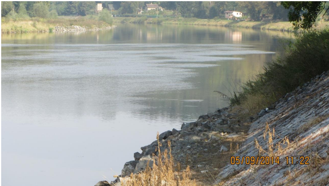
Dlažba z lomového kamene s výplní spár cementovou maltou, opřena o záhozovou patku. Stáří konstrukce asi 70 – 80 let.
