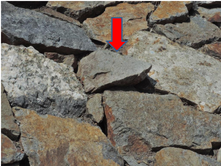
Dlažba z lomového kamene nasucho. Dlažba je uložena na dlouhém svahu a byly do ní občas použity i kameny nevhodného jehlanovitého tvaru. Tlak, který konstrukce na jednotlivé prvky vyvozuje, vede k vytlačování kamenů nad úroveň koinstrukce.
