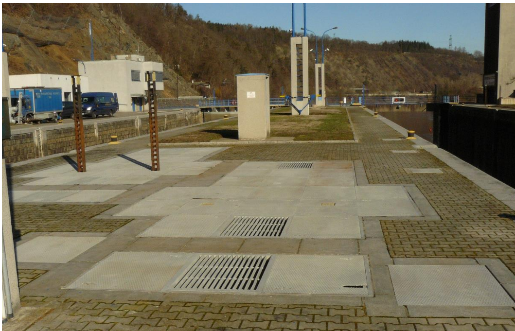
Obr. Pohled na zakryté stavítkové šachty, šachty provizorního hrazení a šachty pro kotvy horních ložisek vzpěrných vrat
