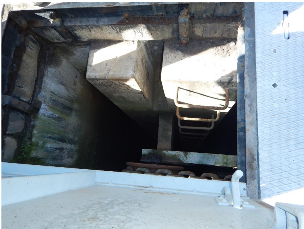
Obr. Pohled na průběžný žebřík ve stavítkové šachtě
