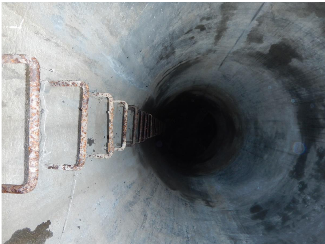
Obr. Pohled na žebřík v šachtě drenáže
