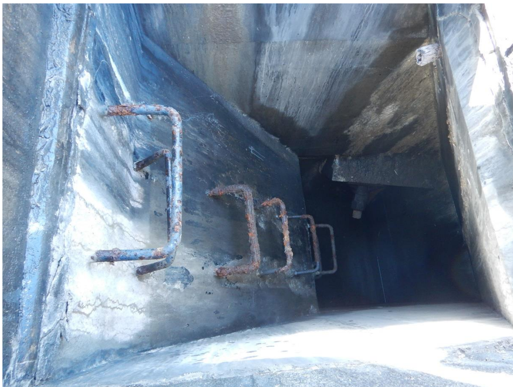
Obr. Pohled na žebřík ve zkosené šachtě pro kotvy horních ložisek vzpěrných vrat
