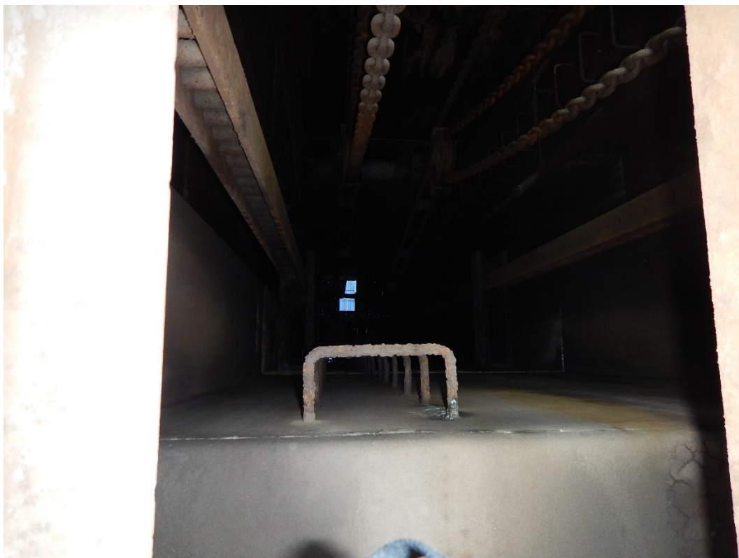
Obr. Pohled na žebřík končící na podestě ve stavítkové šachtě
