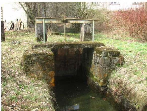
Obrázek 5 - Stavidlový uzávěr výtoku do náhonu.
