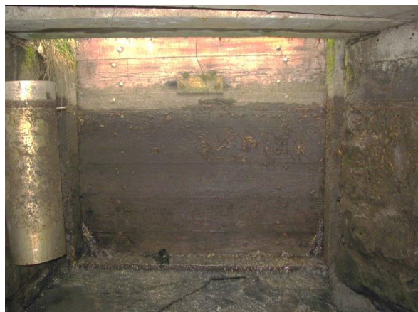
Obrázek 9 - Stavidlový uzávěr nátoku do náhonu, vlevo ochrana odběrného potrubí do vsakovací laguny.
