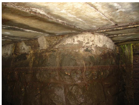
Obrázek 11 - Detail koroze betonu pod stropními prefabrikáty.
