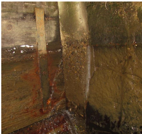
Obrázek 7 - Koroze betonu LB pilířku na vtoku.
