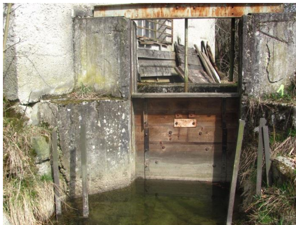
Obrázek 4 - Stavidlový uzávěr nátoky
