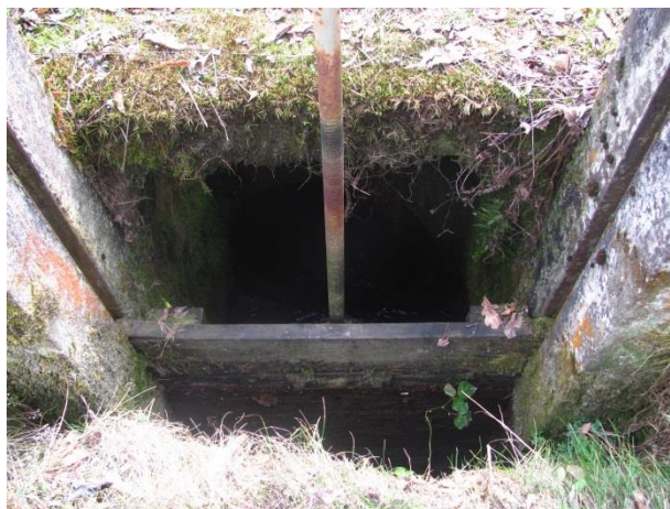
Obrázek 6 - Stavidlový uzávěr jalového obtoku.
