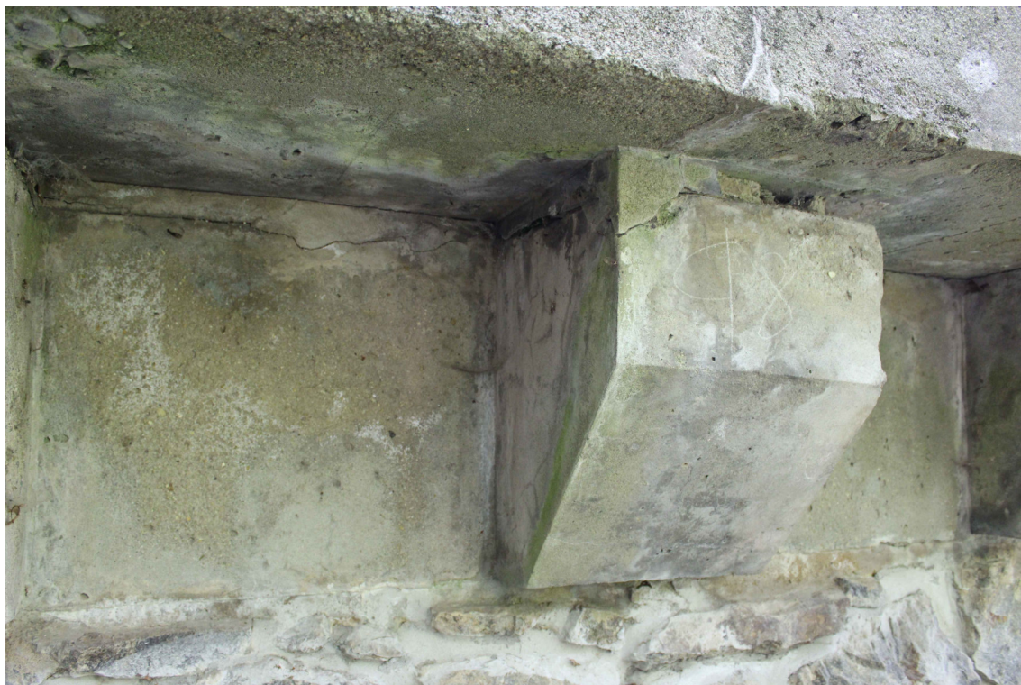
Obrázek 23 – Detail z pravého břehu na betonovou podpěru římsy č. 98
