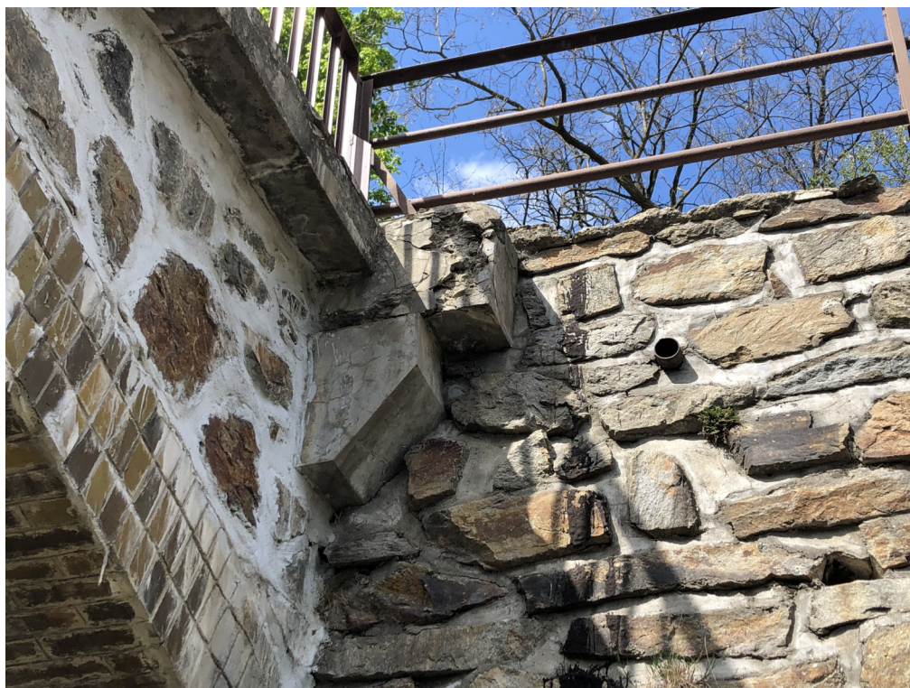
Obrázek 1 – Detail z pravého břehu na betonovou podpěru římsy č. 0
