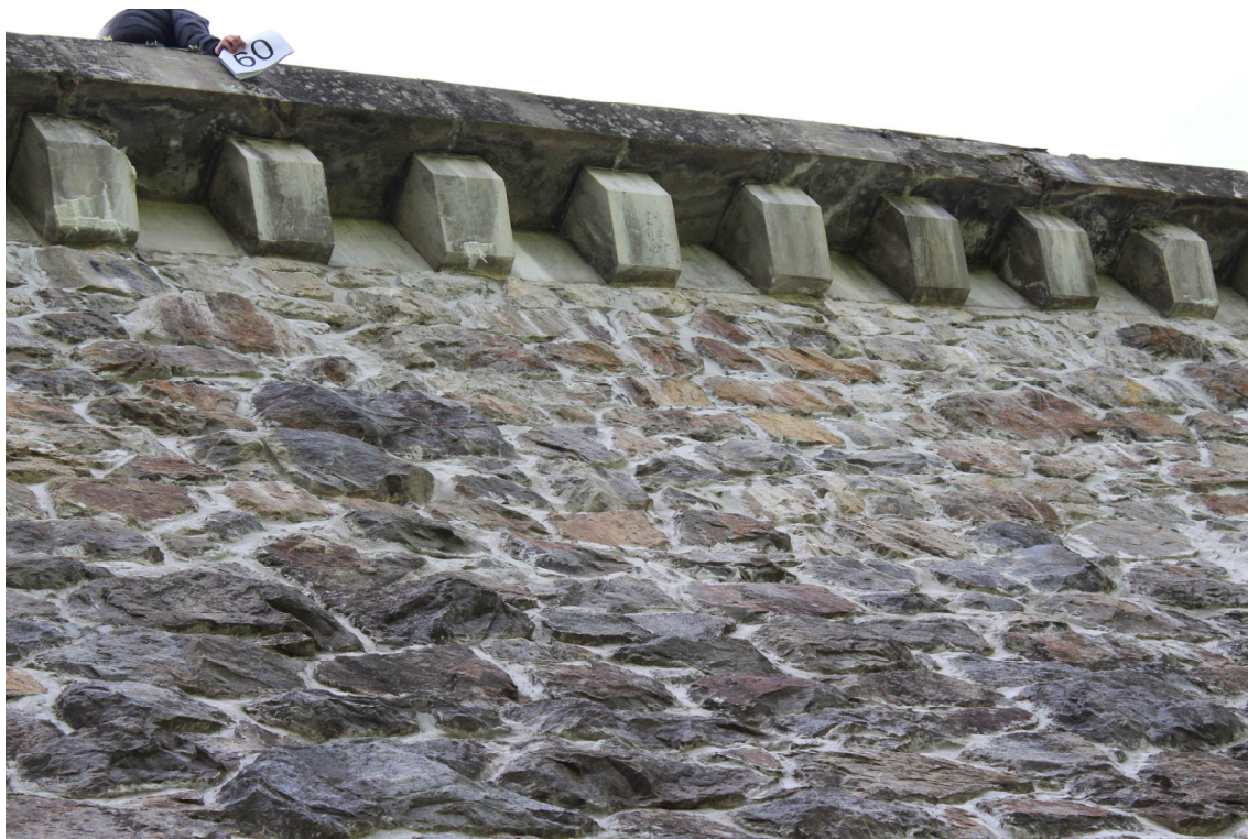
Obrázek 13 – Pohled z pravého břehu na betonové podpěry římsy č. 54 - 61
