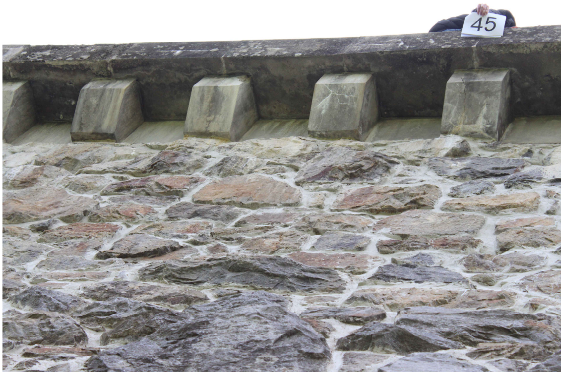
Obrázek 35 – Pohled z levého břehu na betonové podpěry římsy č. 45 – 48
