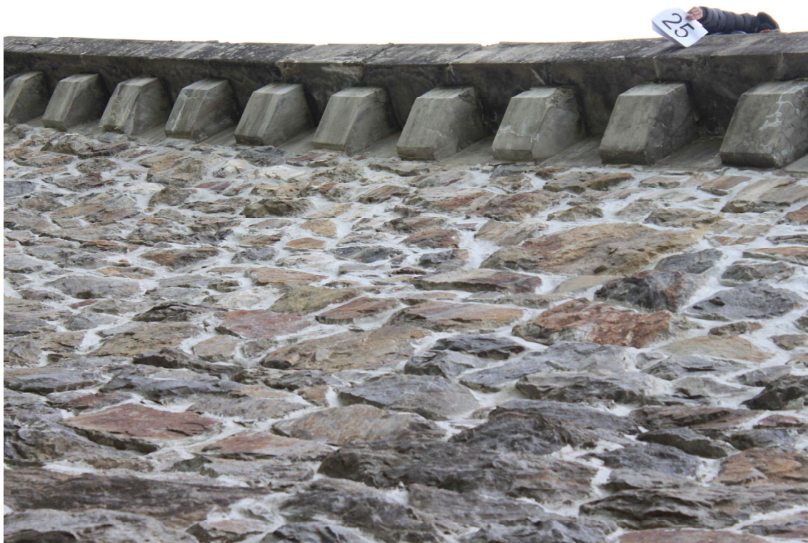
Obrázek 39 – Pohled z levého břehu na betonové podpěry římsy č. 24 – 32
