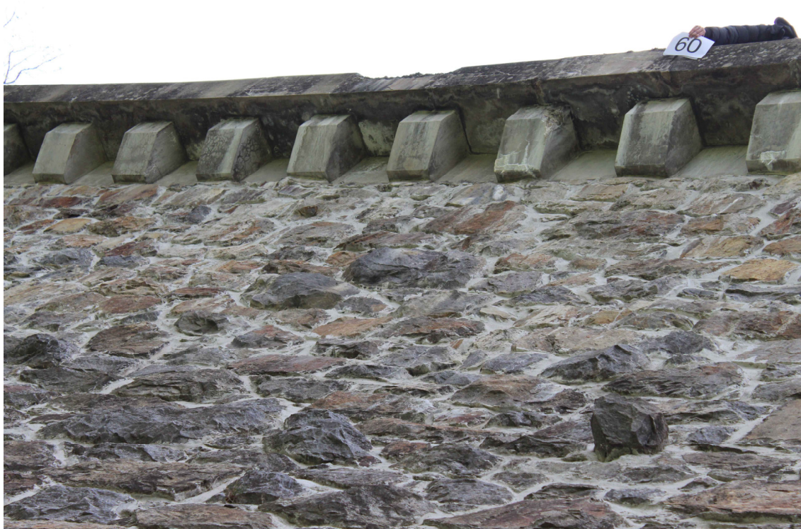
Obrázek 32 – Pohled z levého břehu na betonové podpěry římsy č. 60 – 66
