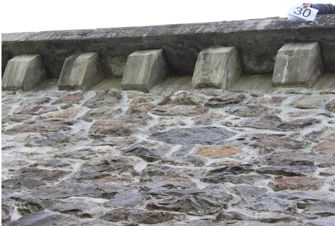
Obrázek 38 – Pohled z levého břehu na betonové podpěry římsy č. 30 – 34
