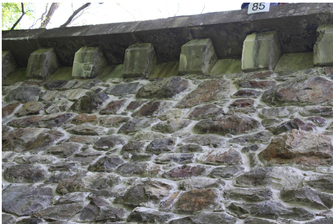
Obrázek 27 – Pohled z levého břehu na betonové podpěry římsy č. 85 – 89
