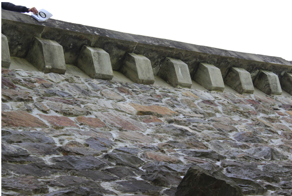
Obrázek 15 – Pohled z pravého břehu na betonové podpěry římsy č. 64 – 70
