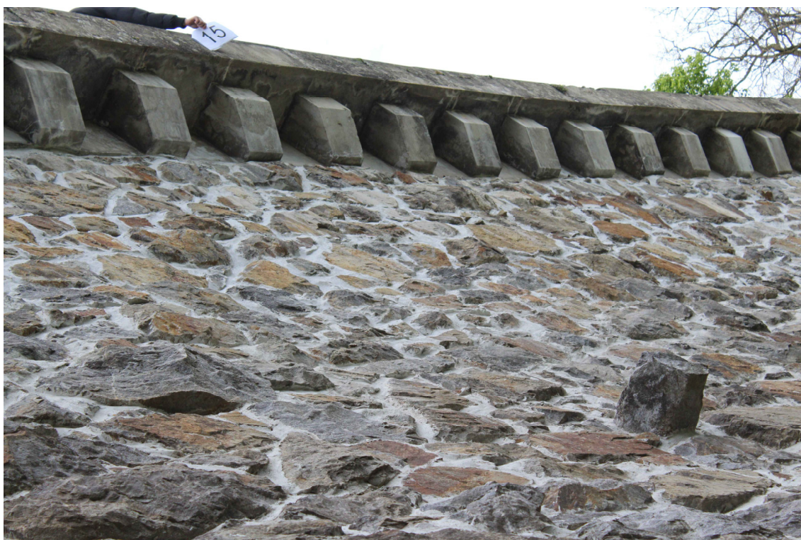
Obrázek 4 – Pohled z pravého břehu na betonové podpěry římsy č. 6 – 17
