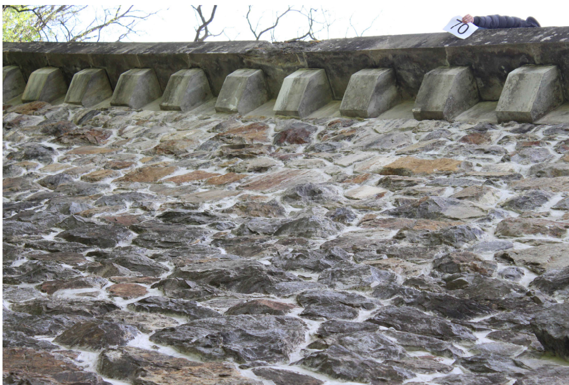
Obrázek 30 – Pohled z levého břehu na betonové podpěry římsy č. 69 – 77
