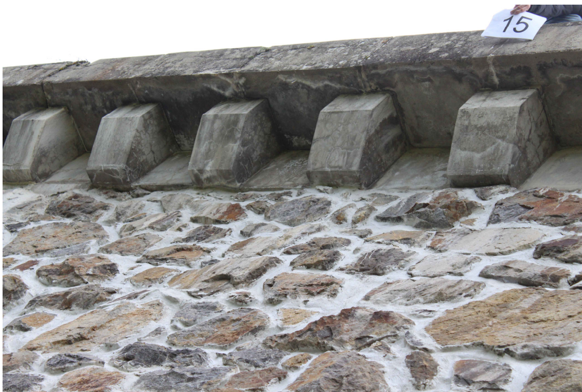
Obrázek 41 – Pohled z levého břehu na betonové podpěry římsy č. 15 – 19
