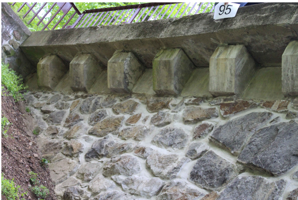
Obrázek 25 – Pohled z levého břehu na betonové podpěry římsy č. 95 – 99
