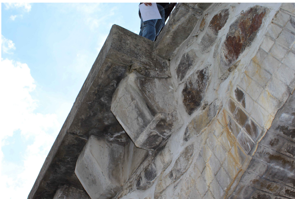
Obrázek 46 – Detail z levého břehu na betonovou podpěru římsy č. 1
