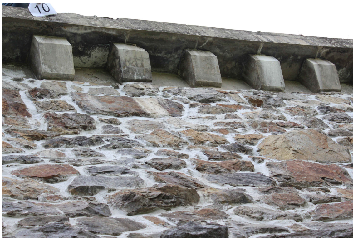
Obrázek 3 – Pohled z pravého břehu na betonové podpěry římsy č. 6 – 10
