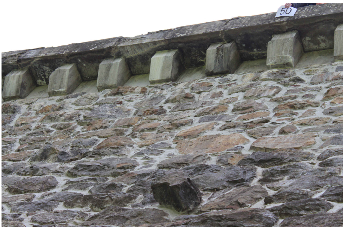
Obrázek 34 – Pohled z levého břehu na betonové podpěry římsy č. 50 – 55
