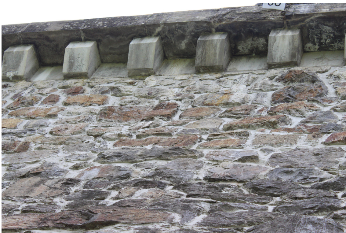
Obrázek 33 – Pohled z levého břehu na betonové podpěry římsy č. 55 – 59
