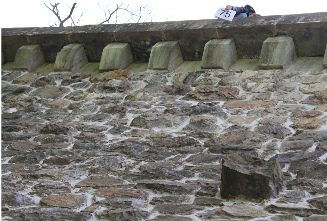
Obrázek 29 – Pohled z levého břehu na betonové podpěry římsy č. 74 – 80
