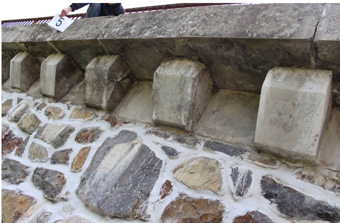
Obrázek 44 – Pohled z levého břehu na betonové podpěry římsy č. 2 – 6
