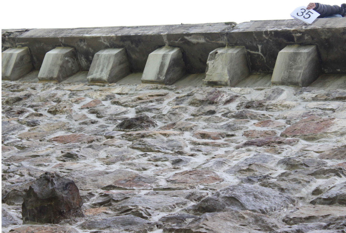
Obrázek 37 – Pohled z levého břehu na betonové podpěry římsy č. 35 – 39
