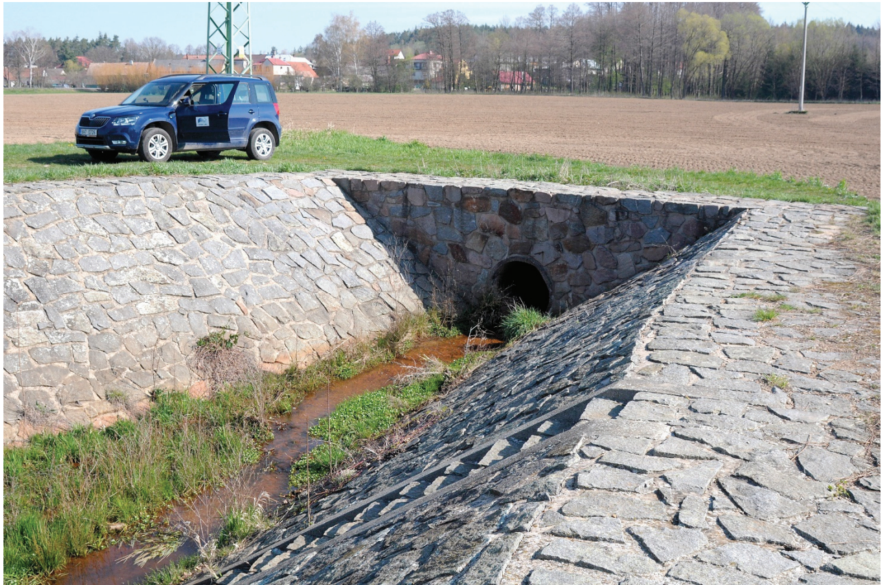
Zaústění do Tiché Orlice
