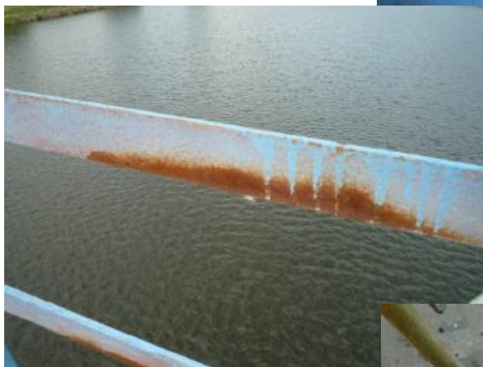
Detail koroze zábradlí
