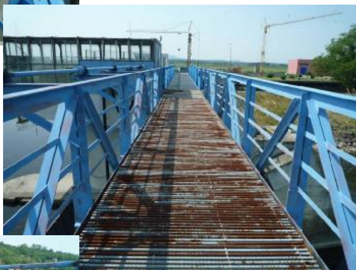
Přechodová lávka – 2. pole – koroze roštů
