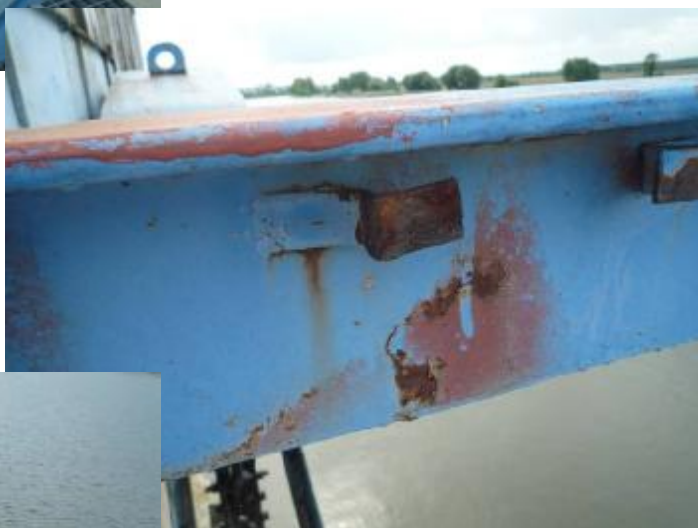
Detail koroze zábradlí
