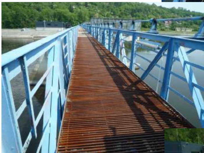
Přechodová lávka – 3. pole – koroze roštů
