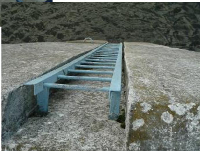
Pilíř č. 6 – přístupový žebřík do vody
