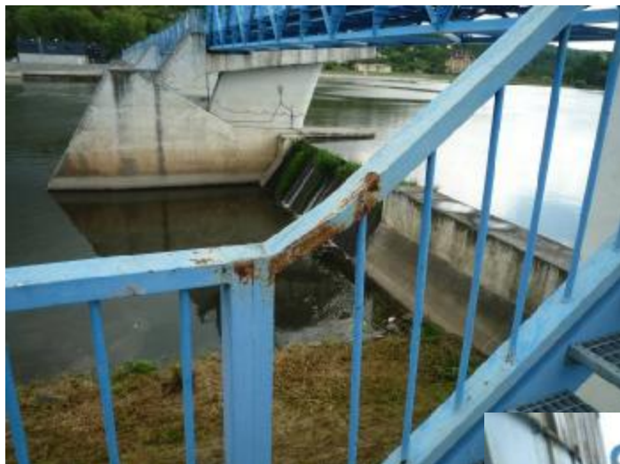
Detail koroze zábradlí
