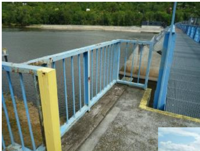
ŽLB podesta – abrazie povrchu, koroze zábradlí
