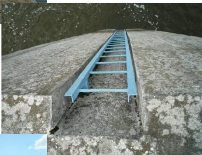
Pilíř č. 4 – přístupový žebřík do vody
