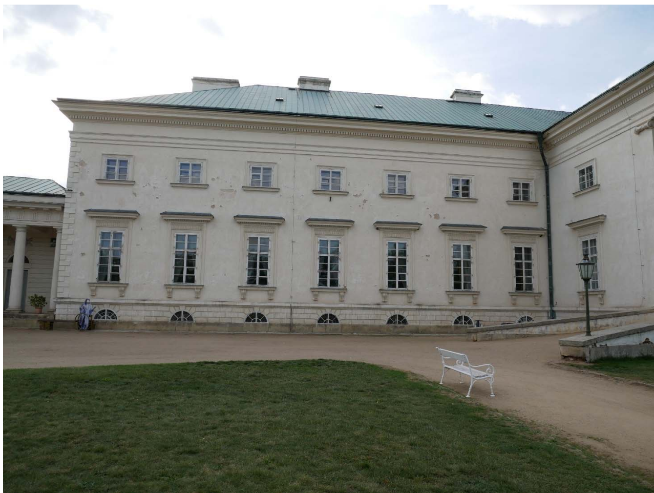
Levá strana fasády
