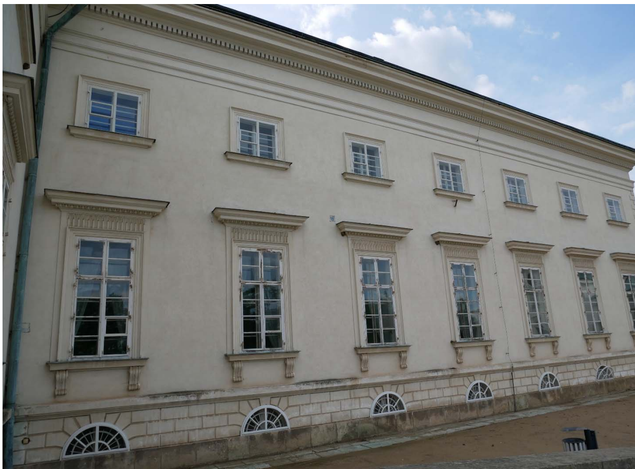
Celkový pohled na pravou stranu fasády
