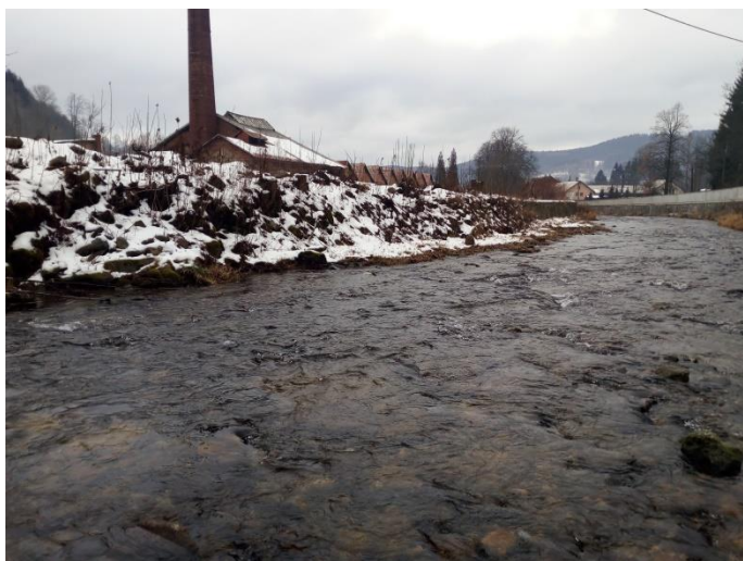
Kamenná rovnanina na LB VVT Desná v ř. km 29,909 – 30,019
