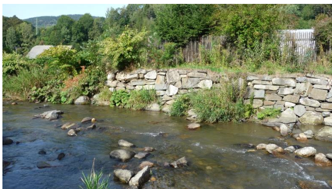
Opěrná zeď na PB VVT Desná v ř. km 30,165 – 30,258
