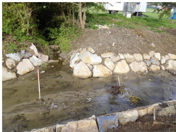
Obr. 20: Opevnění koryta a PB přítoku
