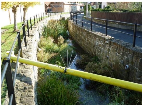
Obr. 51: Koryto vodního toku opevněné opěrnými zdmi
