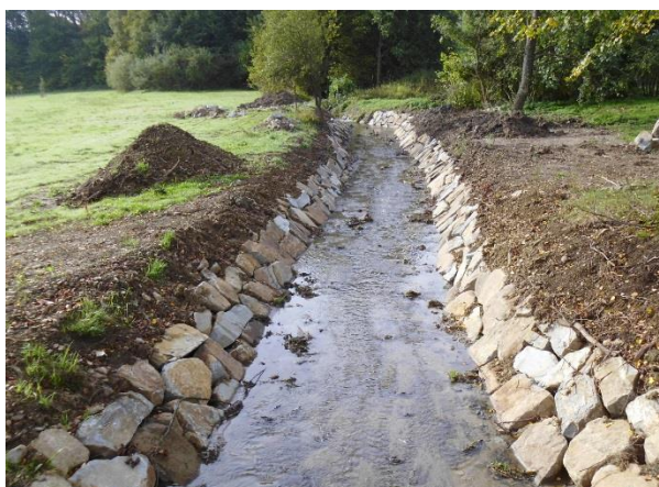
Obr. 21: Opevněné koryto
