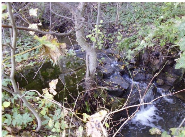
Obr. 23: Kamenný spádový stupeň
