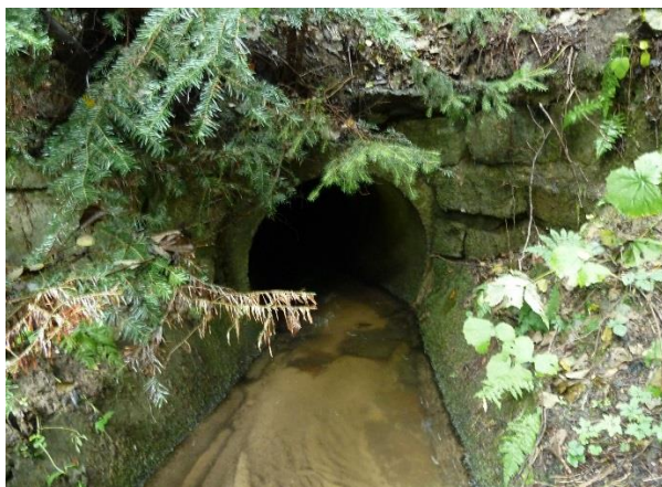
Obr. 53: Propustek
