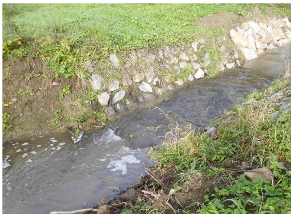
Obr. 19: Přechodová část opevnění koryta
