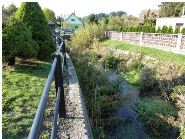
Obr. 49: LB opěrná zídka, PB dlažba, koryto zanesené
