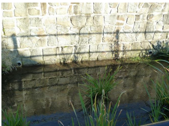
Obr. 53: Pohled PB opěrnou zeď – v patě zdi cca po 3 metrech výustě (odvodnění okolní komunikace)
