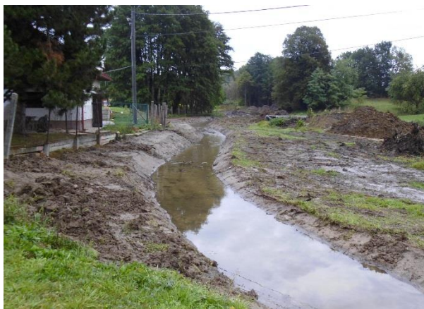
Obr. 25: Zkapacitnění koryta – pohled proti proudu
