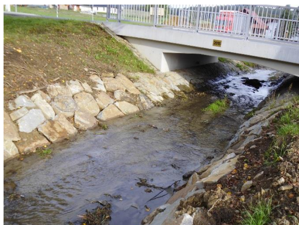
Obr. 22: Napojení nového opevnění koryta na opevnění pod mostem
