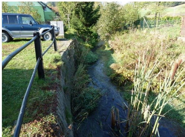
Obr. 47: Koryto Smolinky v intravilánu, pohled po proudu – LB opěrná zeď, nánosy v korytě
