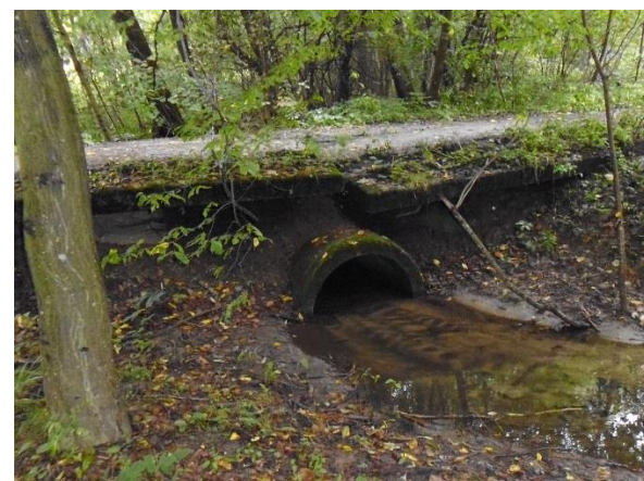
Obr. 46: Zanesený propustek
