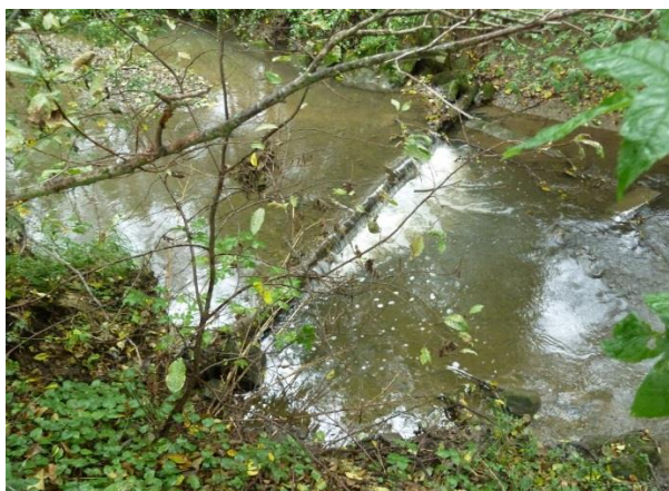
Obr. 3: Dřevěný stupeň v korytě Smolinky
