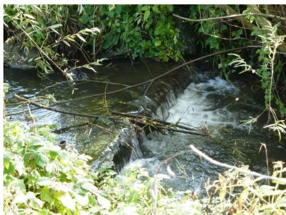
Obr. 43: Dřevěný práh ve dně pod betonovým mostkem v ř. km 7,630
