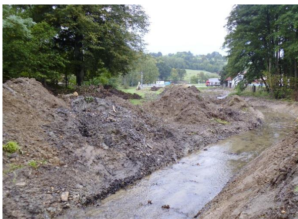
Obr. 27: Zkapacitnění koryta – pohled po proudu
