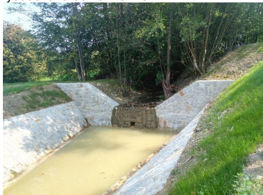
Obr. 36: Kamenná přehrážka v lokalitě UJ-TO-04
