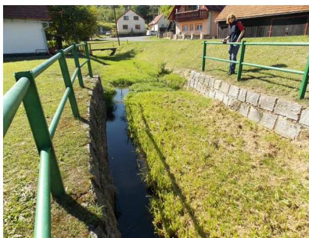
Obr. 98: Pohled na zanesené koryto, obdélníkový profil
