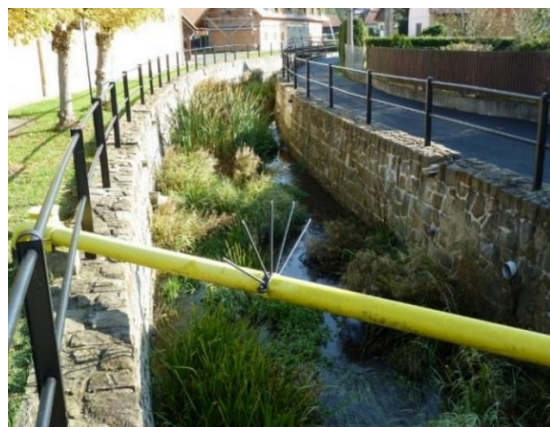
Obr. 59: Pohled na zanesené koryto, obdélníkový profil
