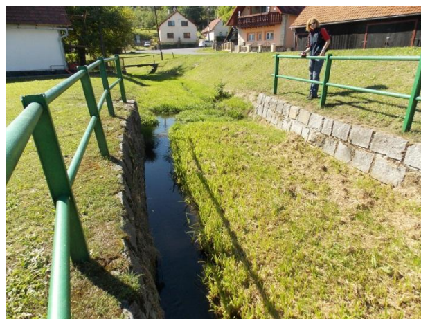
Obr. 47: Pohled na zanešené koryto, obdélníkový profil
