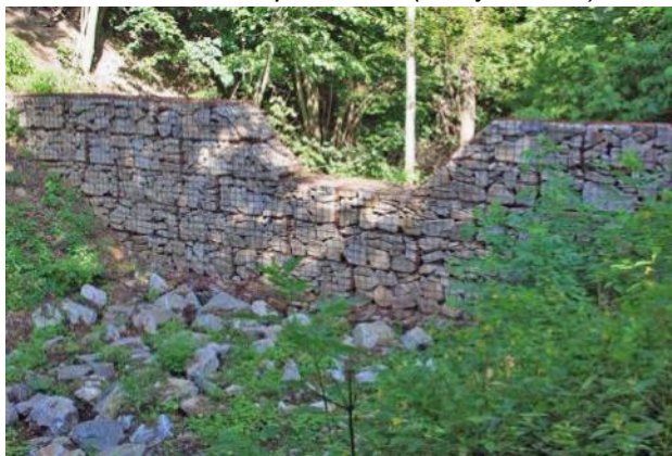
Obr. 11: Drátokamenná přehrážka (zdroj internet)
