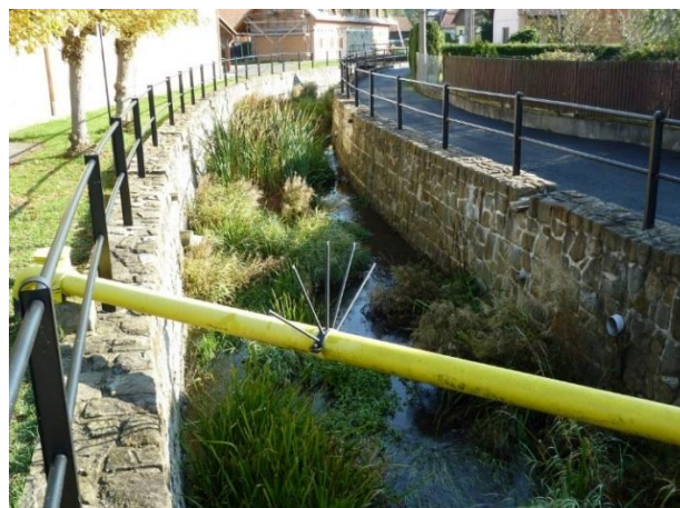
Obr. 36: Pohled na zanešené koryto, obdélníkový profil
