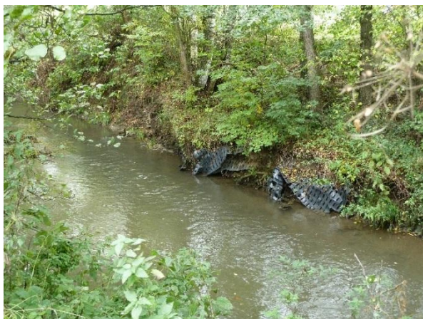
Obr. 78: Narušené gumové opevnění v patě levého břehu
