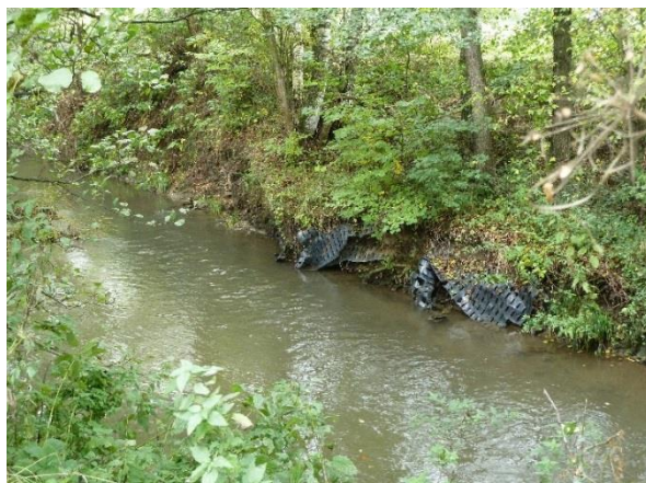
Obr. 25: Narušené gumové opevnění v patě levého břehu
