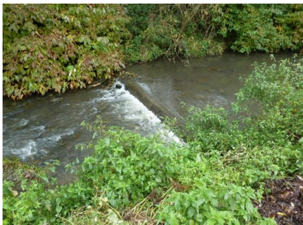
Obr. 13: Dřevěný práh v korytě Vláry cca 30 m pod silničním mostem
