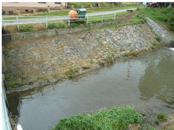
Obr. 22: PB opevnění pod stupněm
