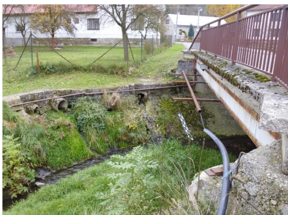
Obr. 49: Silniční most v obci Drnovice – výustě do koryta
