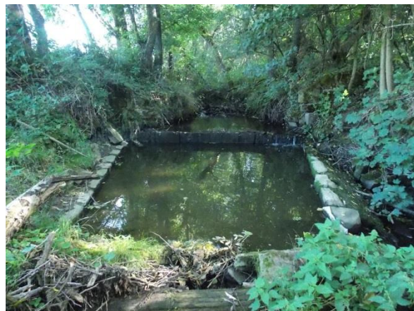
Obr. 42: Kamenný stupeň s vývarem – ve dně vývaru vytvořen dřevěný rošt, ř. km 39,643
