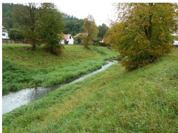
Obr. 18: Lokální zanesení dna a zúžení průtočného profilu
