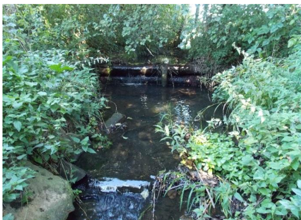
Obr. 9: Dřevěný spádový stupeň ř. km 0,220
