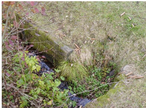
Obr. 9: Vtok do zatrubnění
