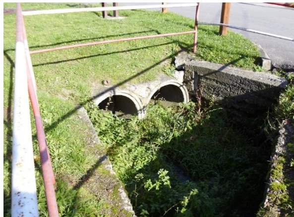
Obr. 22: Vytvoření nových kapacitních propustků
