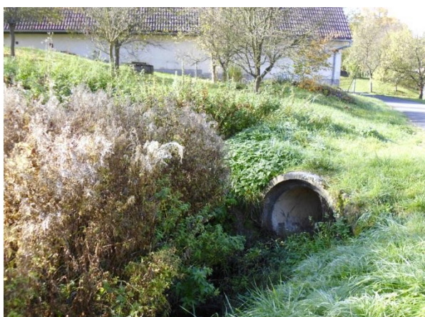
Obr. 23: Vytvoření nových kapacitních propustků
