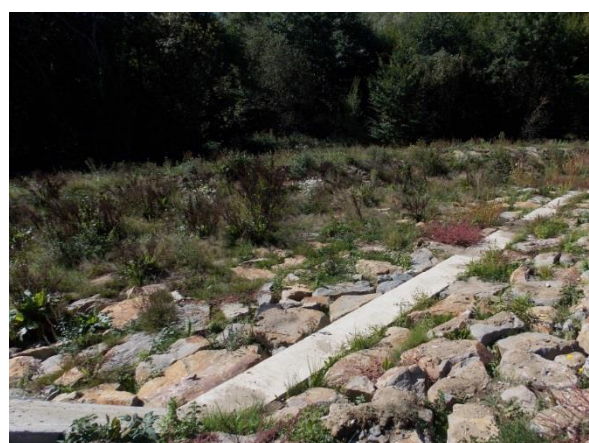
Obr. 69: Stabilizační práh
