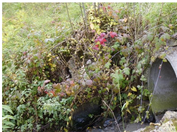
Obr. 11: Výust' zatrubněného potoka
