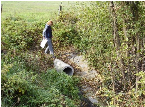
Obr. 14: Výust' z ČOV
