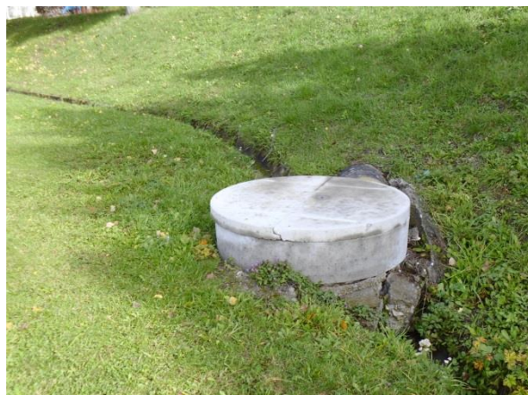
Obr. 32: Revizní šachta
