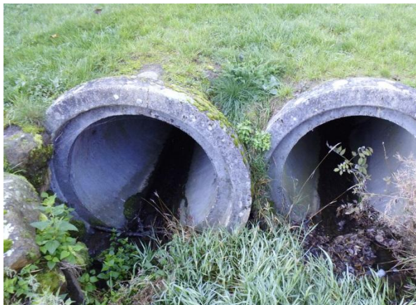
Obr. 21: Vytvoření nových kapacitních propustků
