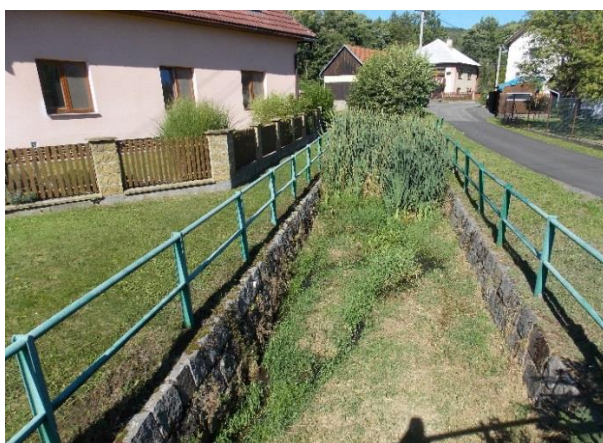
Obr. 34: Pohled proti proudu, stěhovavá kyneta
