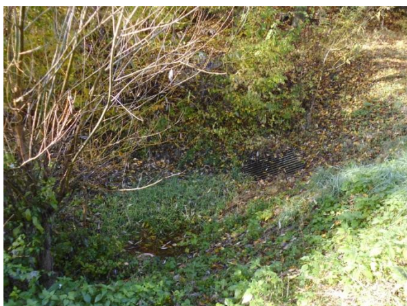
Obr. 77: Zatrubněný úsek potoka s mříží na nátoku – časté ucpání – lokalita VK-3.3
