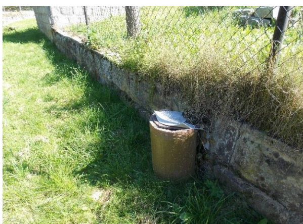
Obr. 56: LB výust' řešená spadištěm
