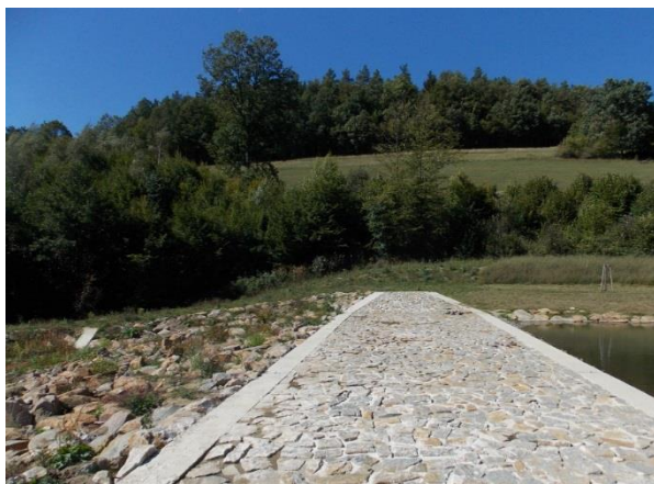
Obr. 70: Bezpečnostní přeliv
