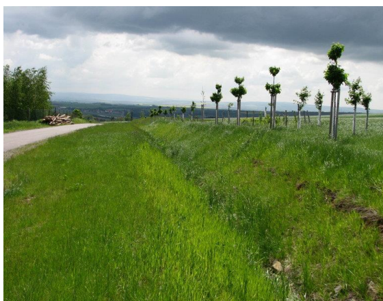
Obr. 8: Příklad protierozní meze se svodným příkopem
