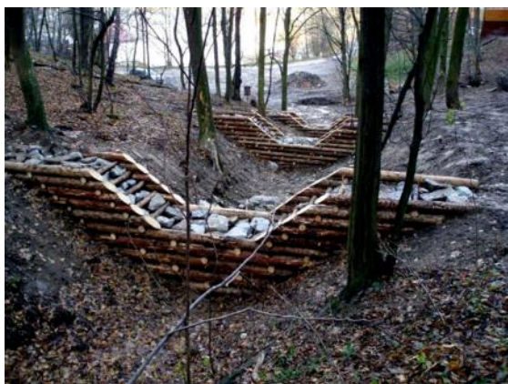
Obr. 14: Srubová přehrážka (zdroj internet)
