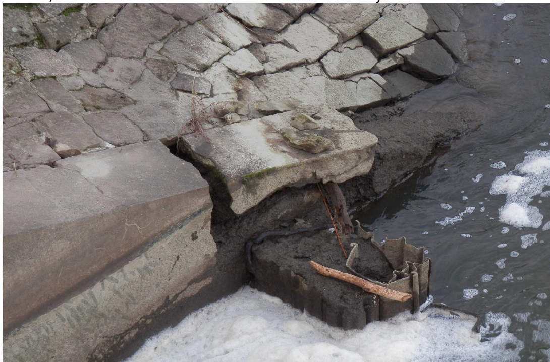
Foto 3,4 – Pohled na zcela oddělené ukončení stěny
