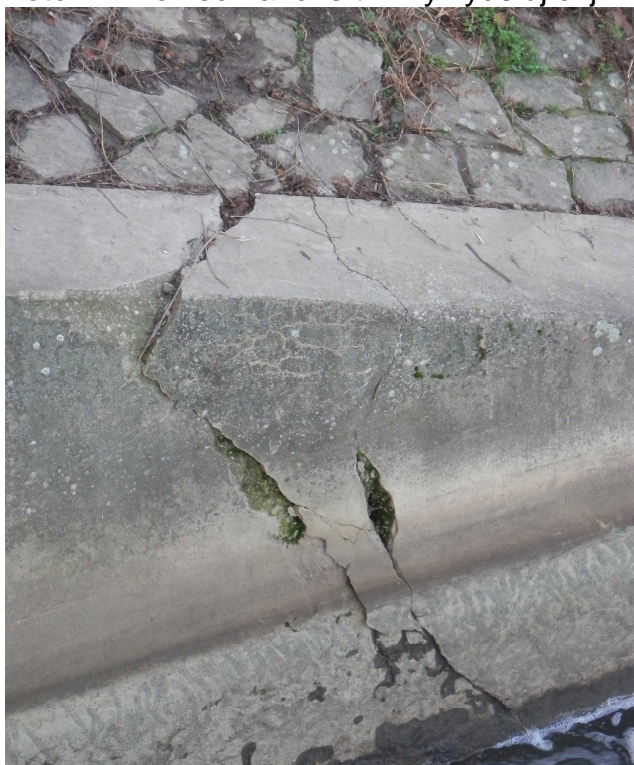
Foto 2 – Pohled na dvě trhliny vydávající již část hmoty stěny
