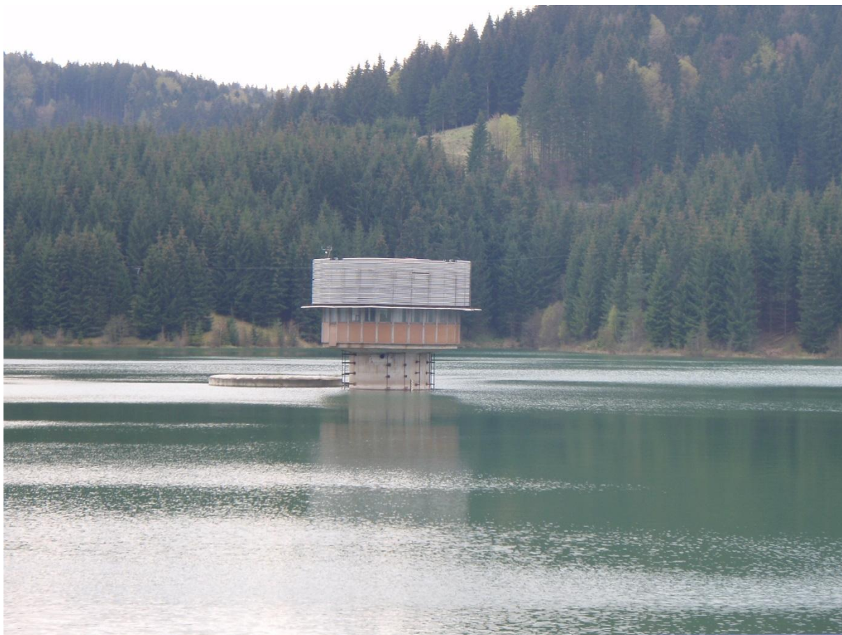
Obr. 1: Odběrná věž se strojovnou v nádrži VD Karolinka
