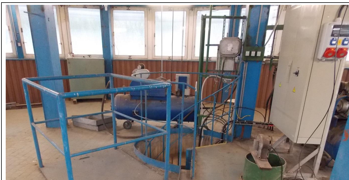
Obr. 3 Vyvedení elektroinstalace přes stropní desku schodišťovým prostorem do strojovny a napojení rozvaděče
