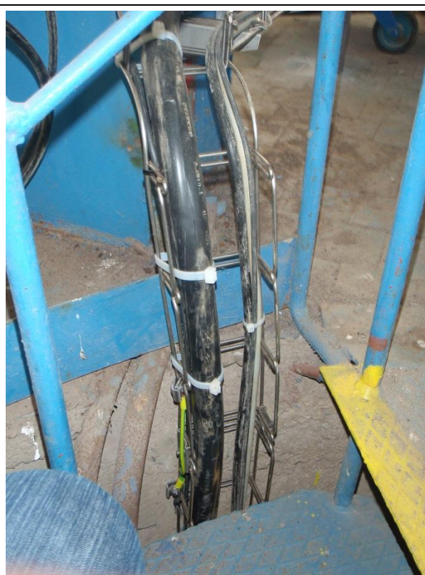
Obr. 2 Detail vyvedení elektroinstalace nad podlahu strojovny
