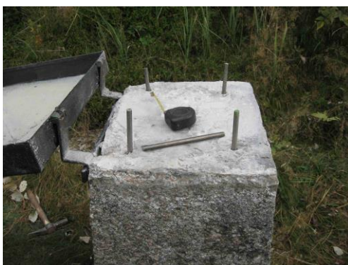
Kotevní prvky levobřežního pilíře po sejmutí horní části Změna nucené centrace, po opravě pilíře
