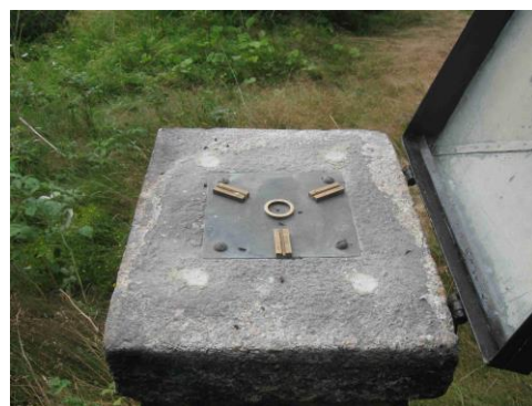
Kotevní prvky levobřežního pilíře po sejmutí horní části Změna nucené centrace, po opravě pilíře
