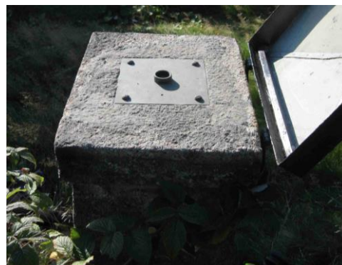
Poškozený levobřežní pilíř, odtržená horní část Původní nucená centrace
