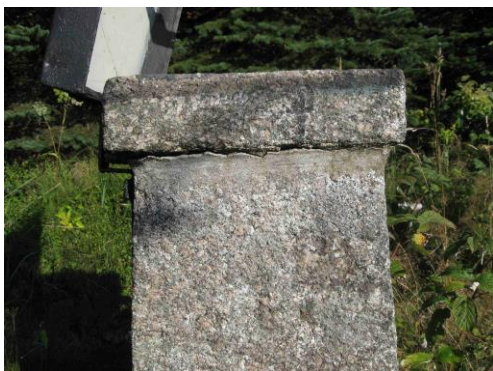
Poškozený levobřežní pilíř, odtržená horní část Původní nucená centrace
