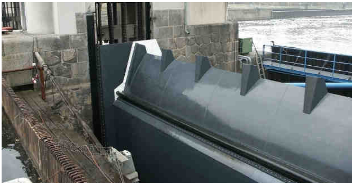
Shodný typ hradící konstrukce již po rekonstrukci z horní vody
