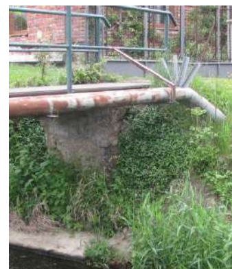
betonové pilíře pod lávkou PB a LB
