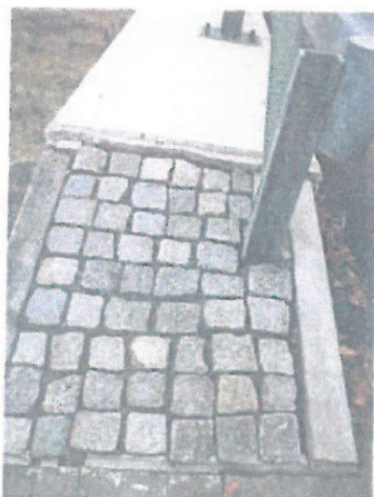
13. Pídlážba zakončení prave římsy na konci mostu
