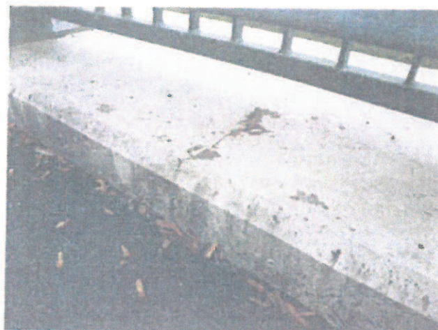
10. Odprskávající nátěr prave římsy
