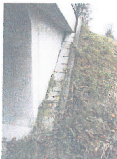
04 Podlažba u levého křídla na začátku mostu
