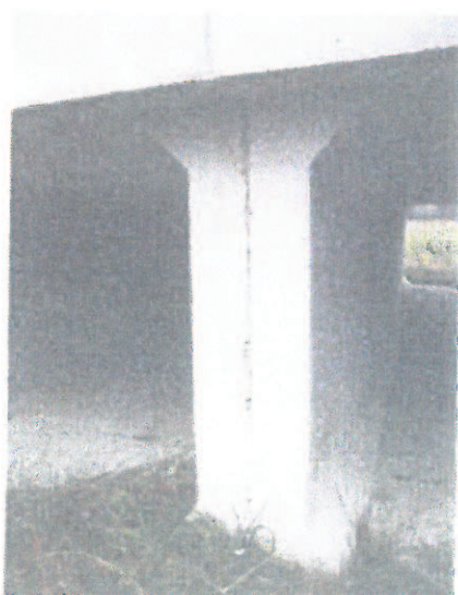
05 Spára mezi prefabrikáty 3 a 4 pole vlevo
