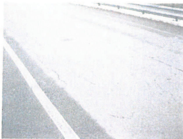
06. Popraskaný kryt vozovky na mostě
