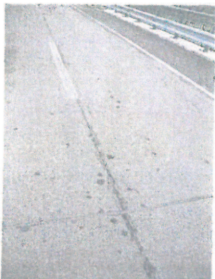
09. Otevřená střední podélná pracovní spára v krytu vozovky
