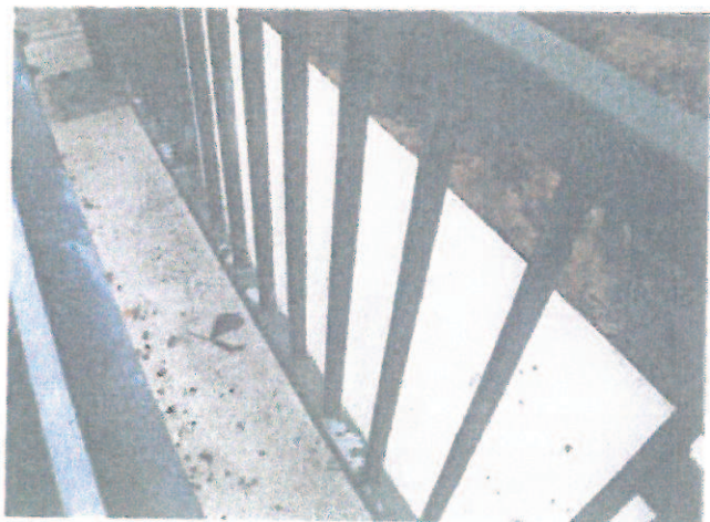
11. Odprskávající nátěr zábradlí
