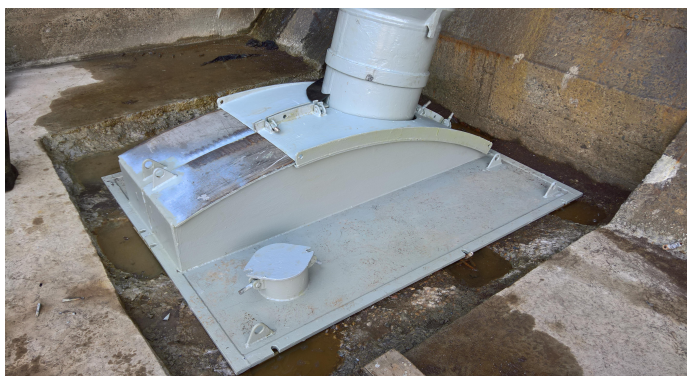
Foto č. 6 – Skříň hydromotoru - pravé jezové pole
