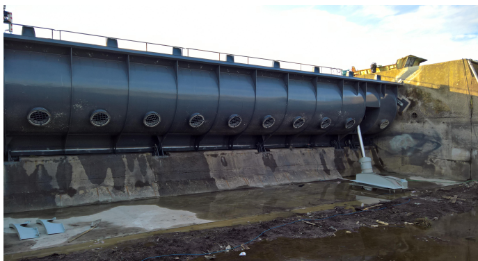
Foto č. 5 – Pohled klapku při opravě – pravé jezové pole
