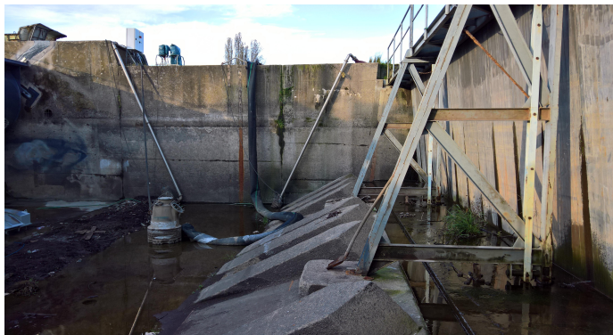
Foto č. 4 – Slupice a hradící systém
