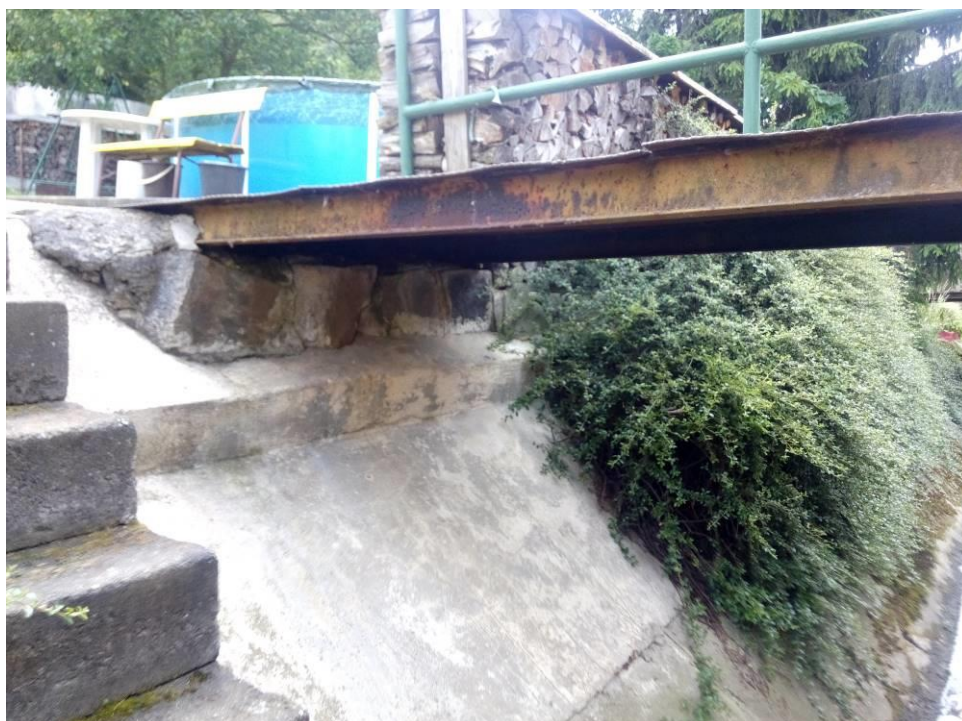
Obrázek 8: Některé bloky pro uložení lávky bude možné vyspravit a zachovat.
