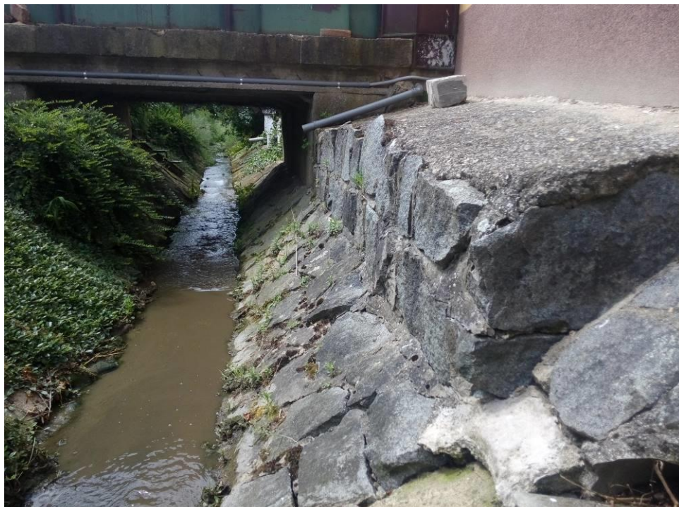
Obrázek 7: Stávající části provedené z kamene do betonu budou opraveny.
