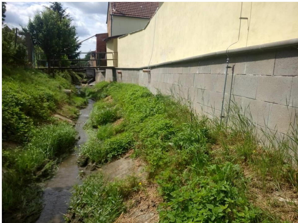
Obrázek 5: Popravný pohled, úsek s navazujícími stavbami na pravém břehu. V pravém břehu je navazující zeď stabilizována bet. blokem. Staničení cca 175-250 m.
