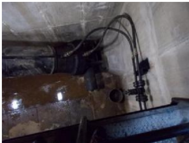
Uchycení hydromotoru - do pilíře
