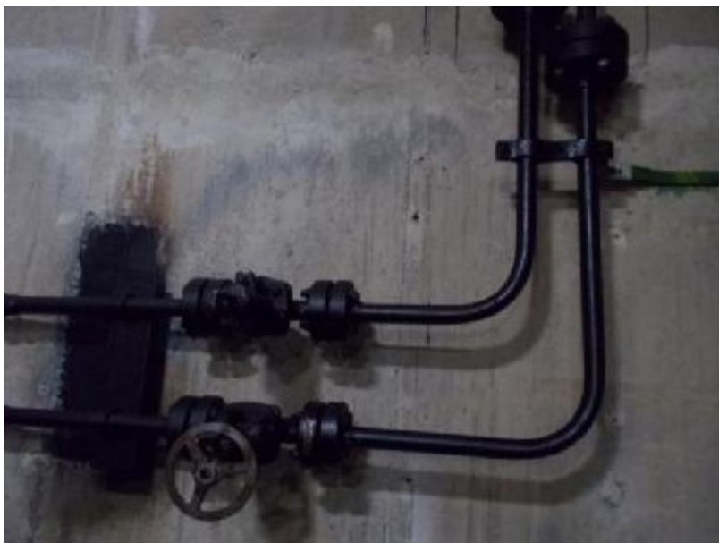
Pohled na uzavírací ventily ve strojovně hydromotoru.
