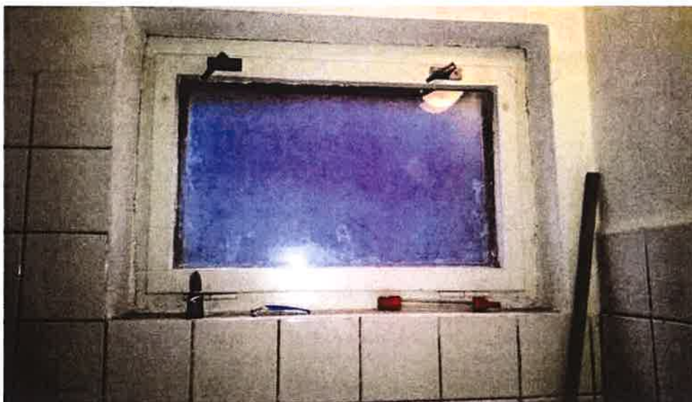
Okno (WC a umyvárny)
