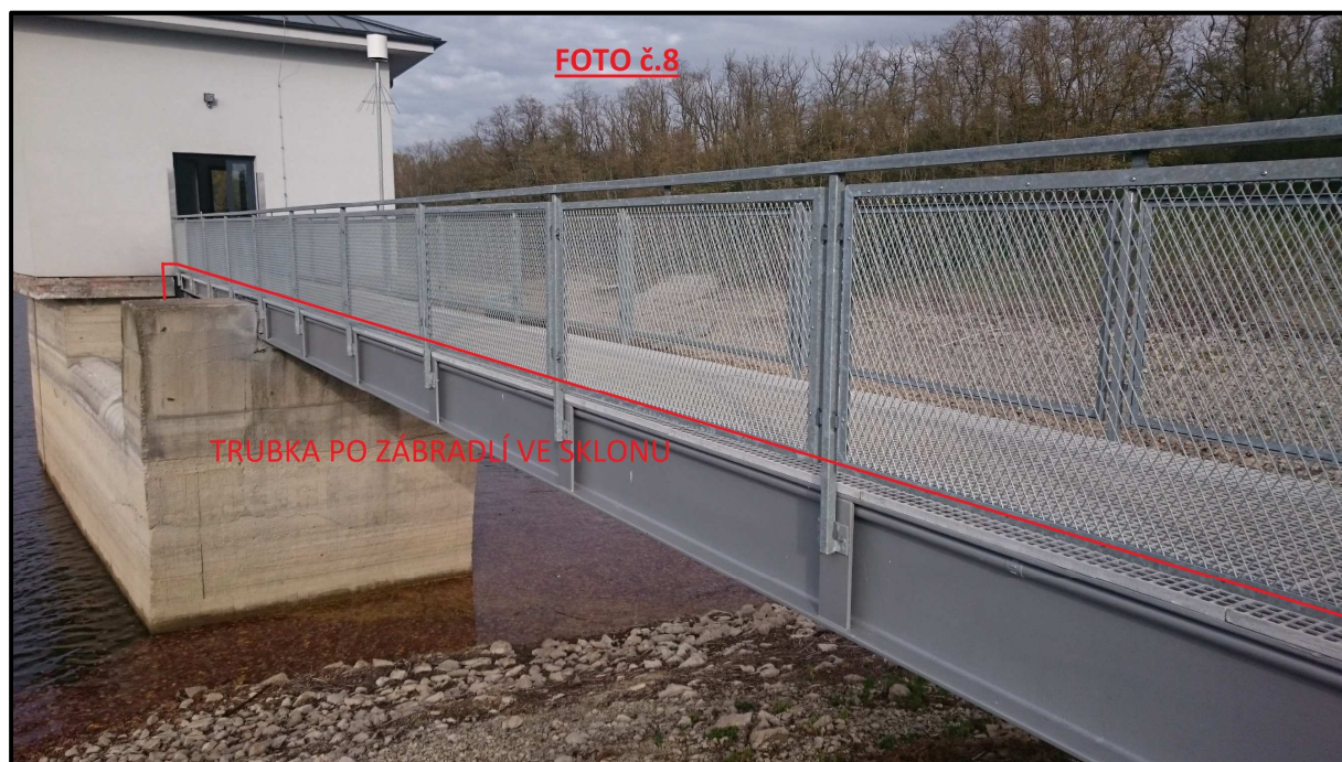
Sdružený objekt – umístění potrubí ve sklonu na lávce
