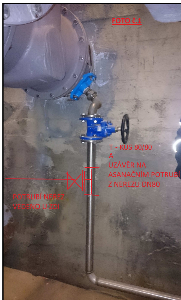
Sdružený objekt – napojení na asanační potrubí
