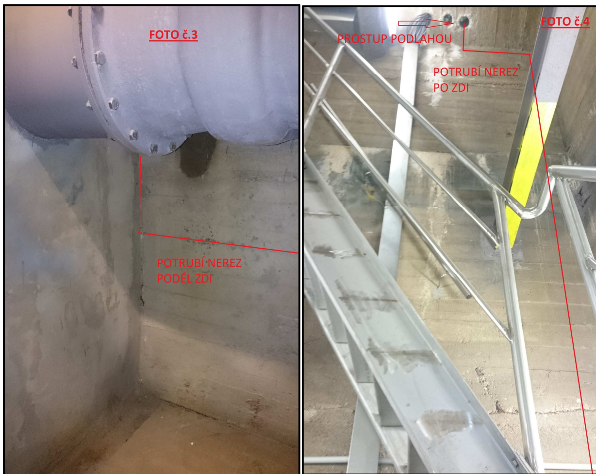
Sdružený objekt – výtlačné potrubí od čerpadla
