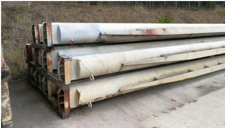
Trubky provizorního hrazení segmentů
